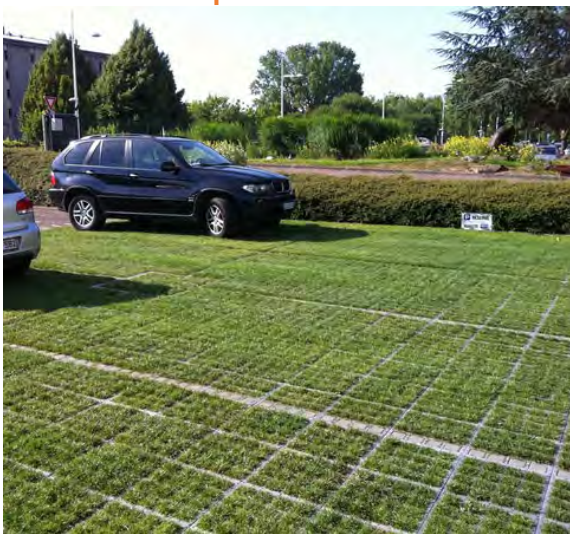
Parkeren op grasbeton
