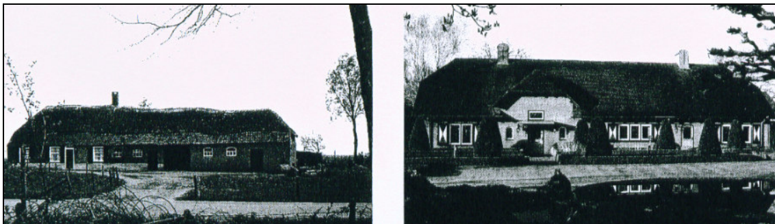
Afbeelding 13: Links staat de in 1974 gesloopte boerderij afgebeeld en rechts de huidige bebouwing.
