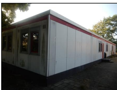
Figuur 6. Tijdelijke bebouwing.
