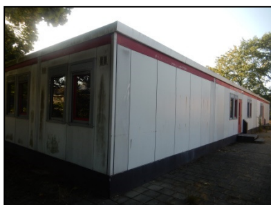
Figuur 6. Tijdelijke bebouwing.
