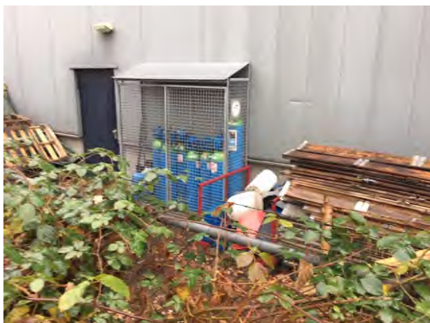
f5.1 Gasflessenopslag metaalbewerkingsbedrijf P.S.N., Spegelt 50
