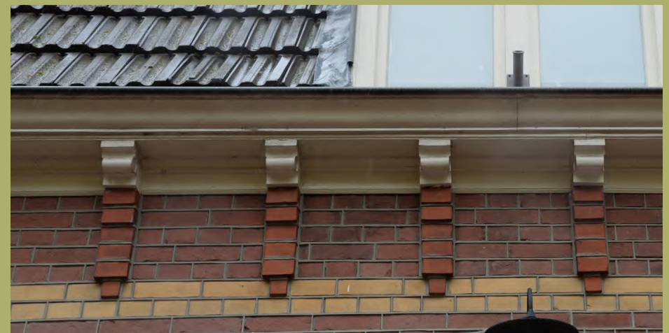
Opvallende daklijsten, siermetselwerk en afwijkende plinten
