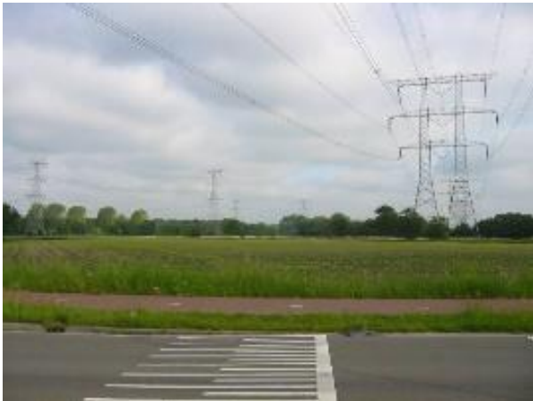
Hoogspanningmasten over Wolvendijk
