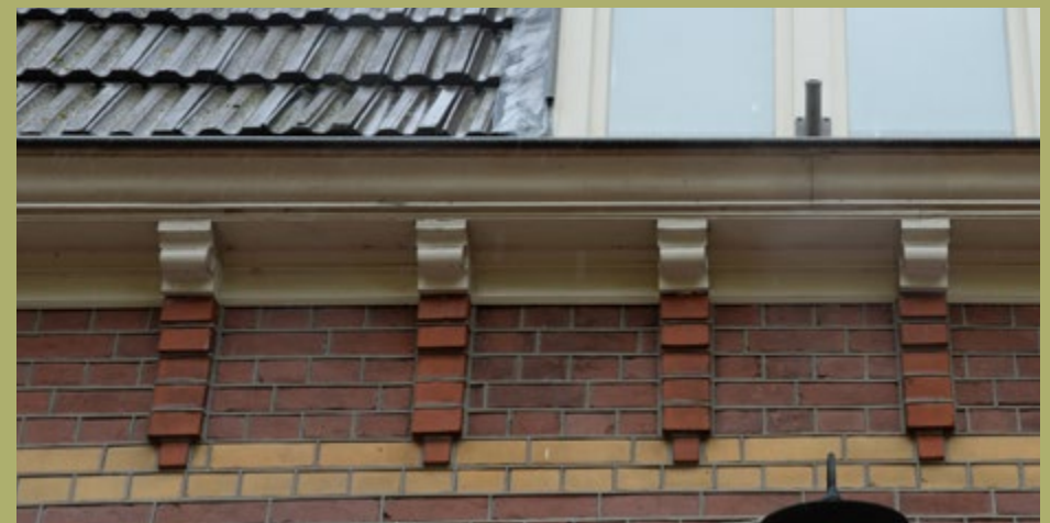
Opvallende dakklijsten, siermetselwerk en afwijkende plinten
