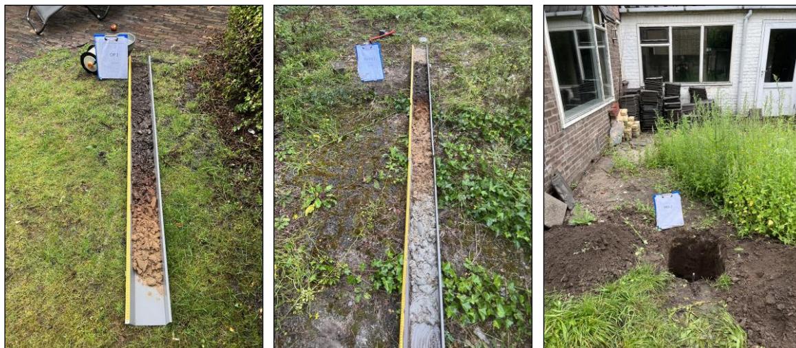
Figuur 1: Impressie van de onderzoekslocatie aan de Pastoor Aldenhuijsenstraat 7-9-11 in Nuenen en uitgevoerde werkzaamheden: links: boorprofiel en omgekeerde putproef OP1, midden: diepe boring 2 en bepaling grondwaterstand en rechts: kuil ten behoeve van ring-infiltratiemeting 2.
