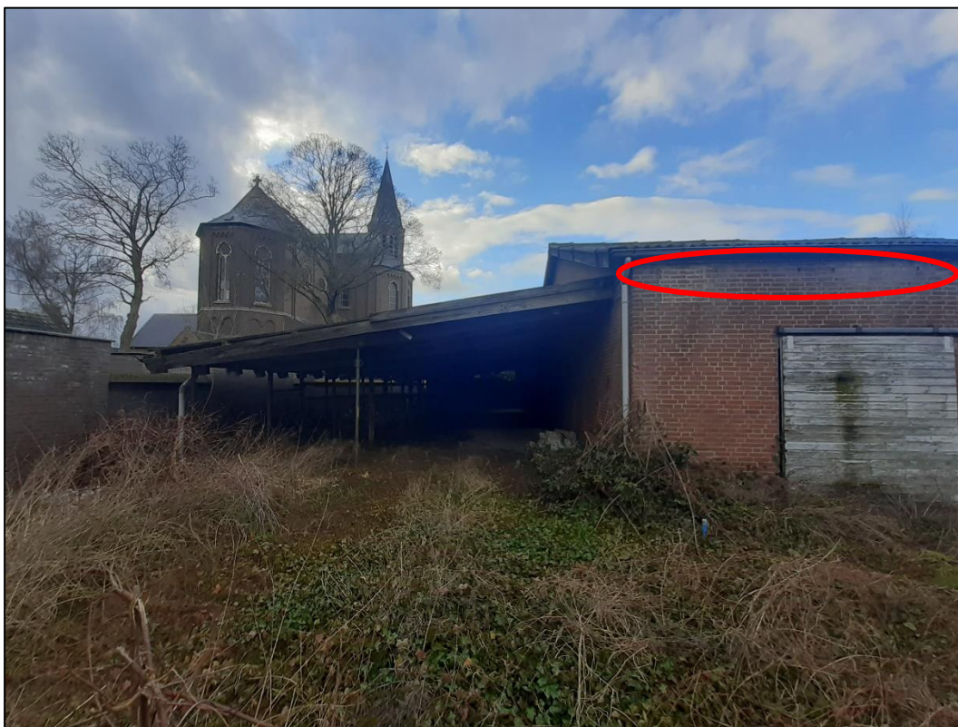
Foto 3: Overkapping aan achterzijde grote schuur. Rechts zijn ook enkele van de open stootvoegen te zien boven de toegangspoort (rood omlijnd).
