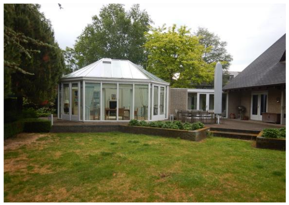
Serre met kelder gebouwd in 2001
