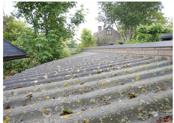
Nt-golfplaat afdak aan het bijgebouw
