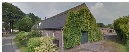
Mansardekap | bestaande situatie
