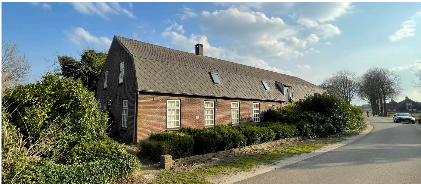
Voorgevel aan de Dubbestraat
