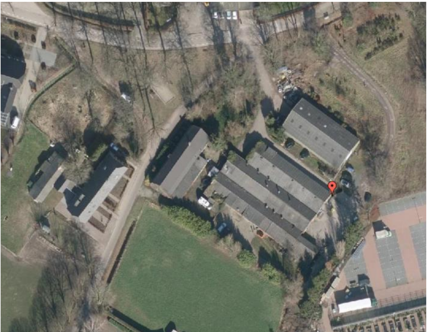
Luchtfoto, huidige situatie
