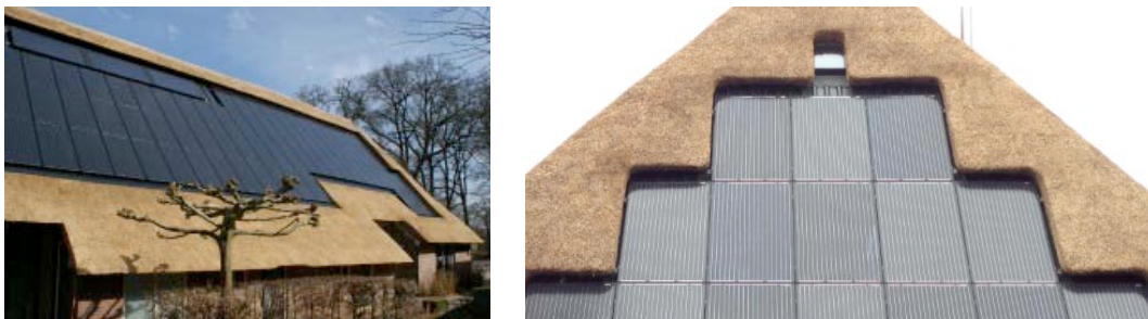
Figuur 16 Referentie zonnepanelen direct op en in dakvlak
