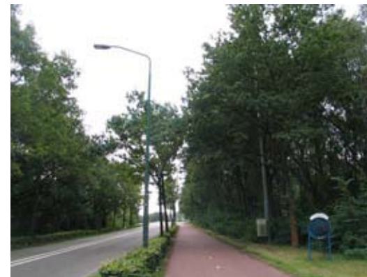
Figuur 4.39 Geldropsedijk met aan de rechterzijde de planlocatie
