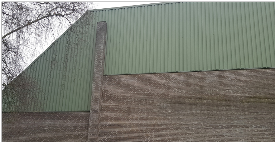
Figuur: er zijn geen open stootvoegen of andere openingen aanwezig in de sporthal waar vleermuizen naar binnen kunnen. Het gebouw is ook niet geschikt voor gierzwaluw of huismus.
