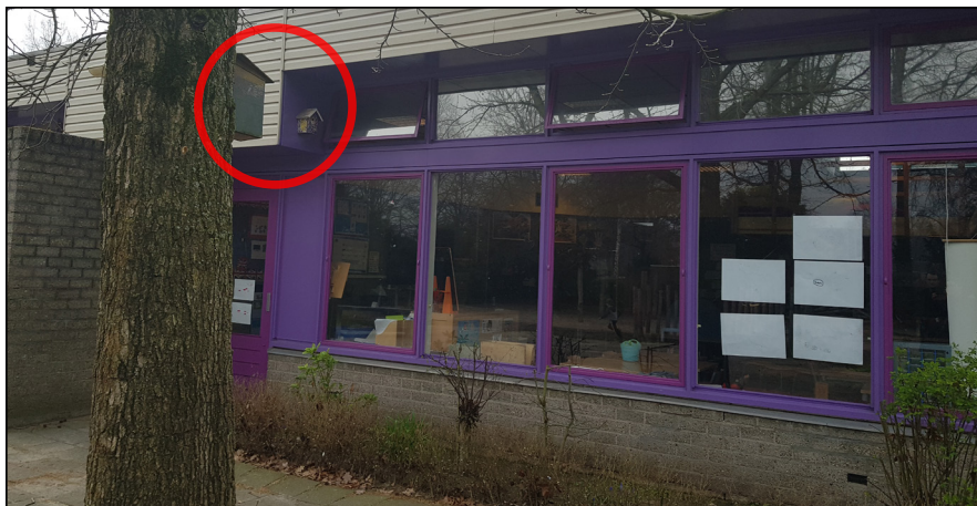
Figuur: twee van de drie mezenkasten die aanwezig zijn aan en rond de basisschool, waar soorten als pimpelmees en koolmees in kunnen broeden.
