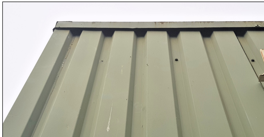
Figuur: er is geen ruimte tussen de metalen platen bij de dakrand waar vleermuizen in kunnen kruipen.
