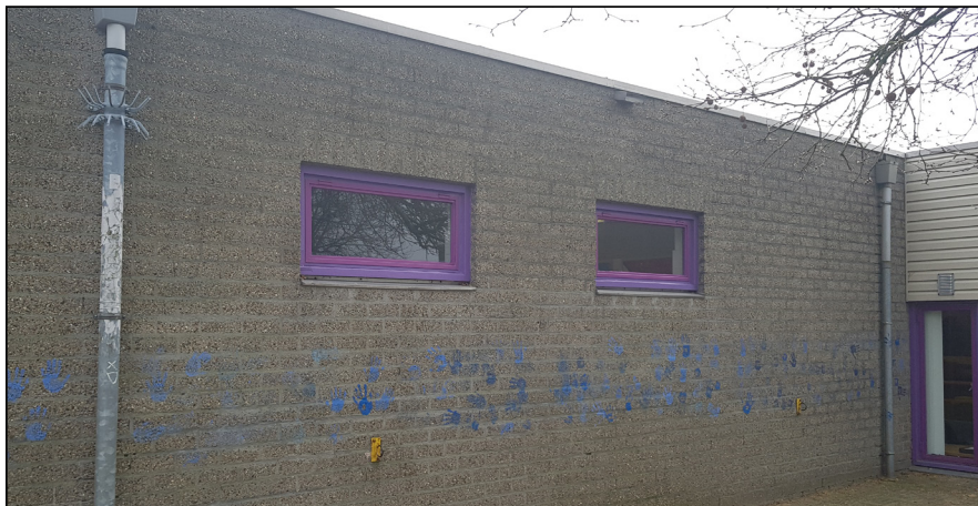
Figuur: er zijn geen open stootvoegen of andere openingen aanwezig in de basisschool waar vleermuizen naar binnen kunnen. Het gebouw is ook niet geschikt voor gierzwaluw of huismus.
