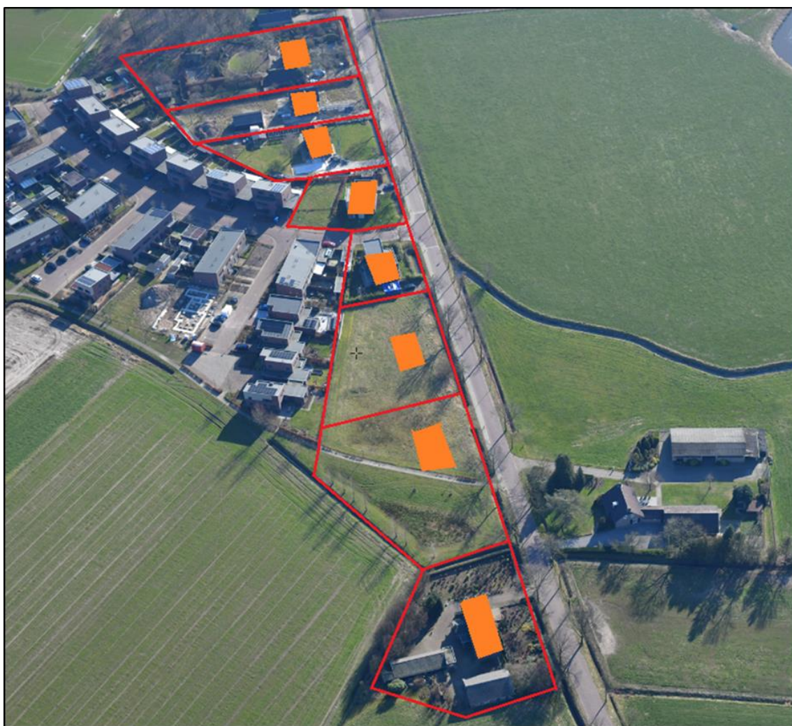
Hoekstraat 84 als eindwoning van de samenhangende structuur van de woningen aan de Hoekstraat (gezien vanuit het noorden). De onderste kavel op de afbeelding is het plangebied van dit bestemmingsplan.
