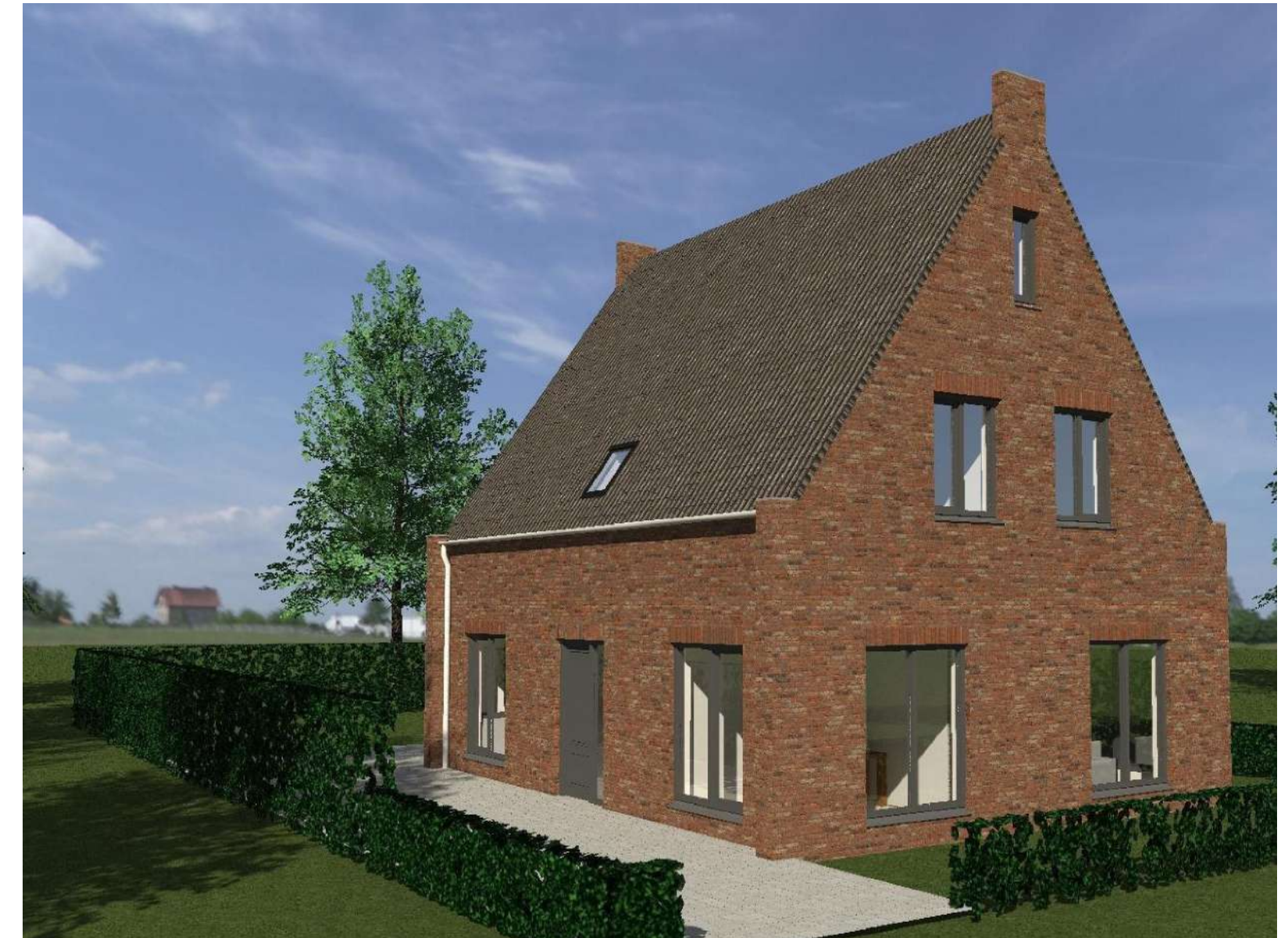
Positief: vormgeving, baksteenkeuze en raamindeling Let op: kleur kozijnen en hoogwaterafvoer niet passend
