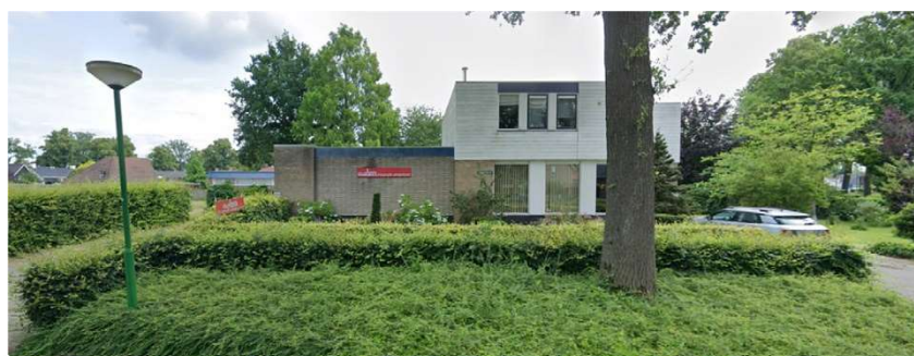
Belendend perceel aan zuidzijde plangebied (Emmastraat 2-4)
