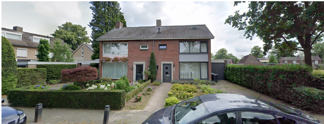
Belendend perceel Emmastraat 12 & 10
