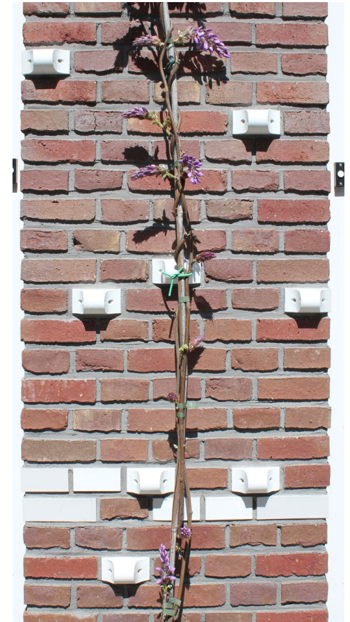
Groenegevel langs 'Bind klinkers'.
