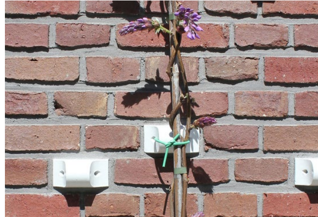
De 'Binderklinker' van Cris Kabel waarlangs groen kan groeien
