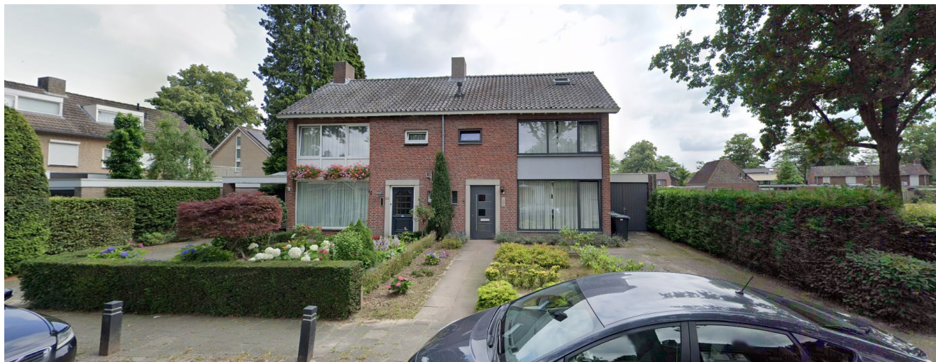
Belendend perceel Emmastraat 12 & 10
