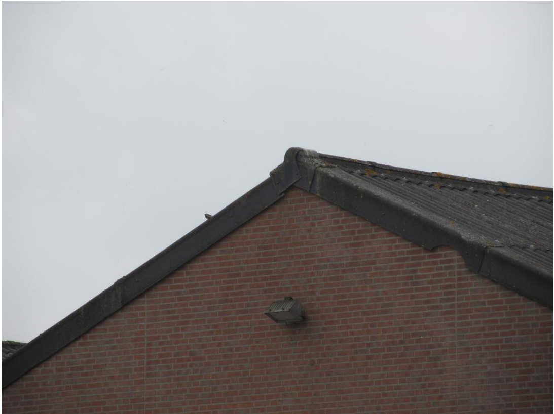
Foto 6: Kopse gevel van de zuidelijke schuur met omgeslagen rand die mogelijk een verblijfplaats kan zijn voor vleermuizen. Op het dak zit een huismus te tjilpen.
