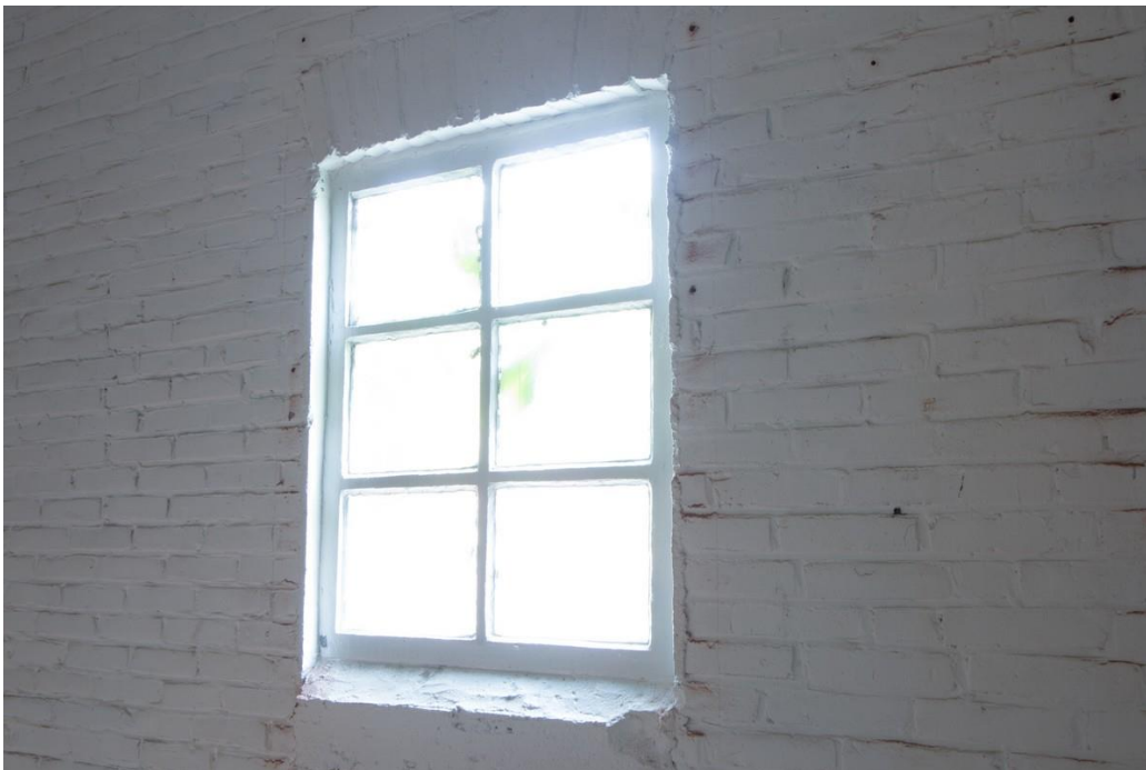
Een niet-oorspronkelijk betonraam in de korte rechterzijgevel, op zolderniveau.
