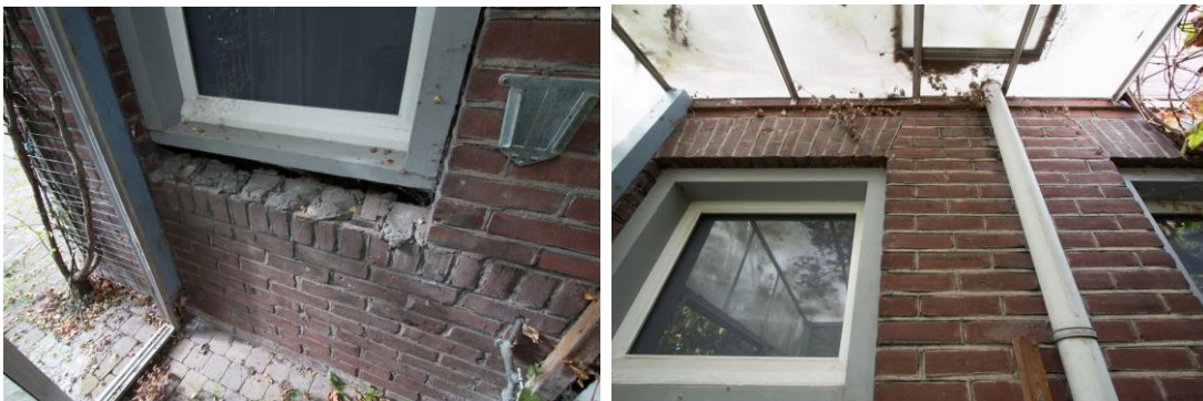
De vensters van de keuken zijn smal en hoog. Het is gebruikelijk om keukenvensters een andere vorm te geven dan vensters van woonkamers (dat geldt overigens ook voor eetkamervensters). Ze zijn sinds de bouw ongewijzigd. Links is wel een onderdorpel verdwenen.
