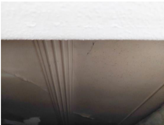
In de kamers gaan stucplafonds schuil boven verlaagde balkenplafonds.
