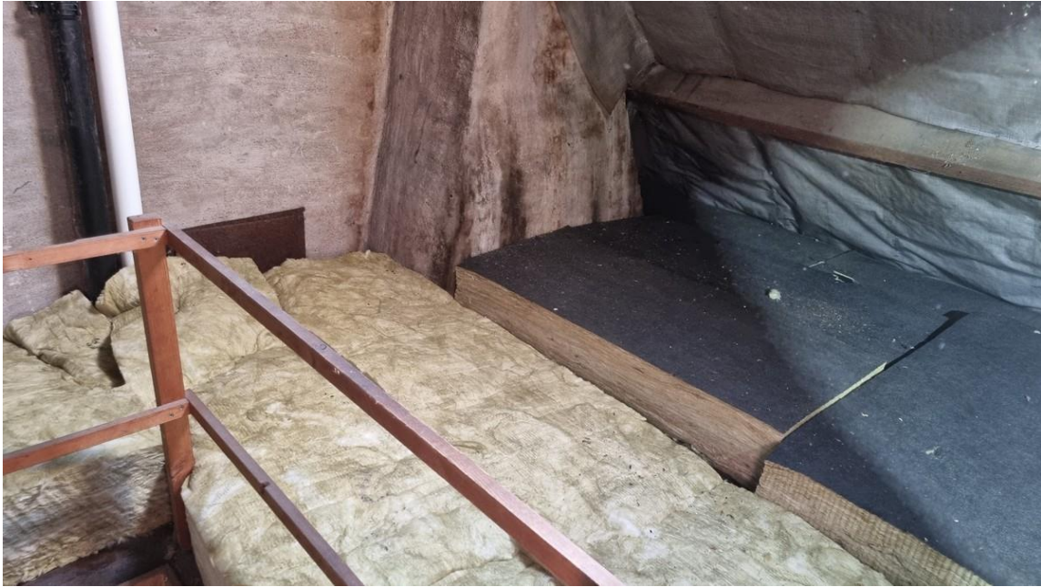
De isolatie op de vloer. In het midden het rookkanaal vanuit de keuken.
