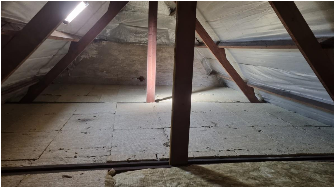
De vlieringzolder richting de straat gezien.
