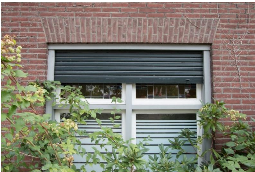
Deel van het venster van de achterkamer, in de linker zijgevel. Kozijn, ramen, rolluik en glas-in-lood zijn uit de bouwtijd. Oorspronkelijkheid van de kleurstelling is niet bekend.
