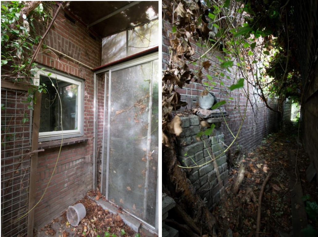
In de korte rechter zijgevel zien we een tot vensteropening vermaakte deuopening. De gevel staat kort op de perceelsgrens.
