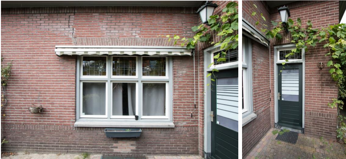
De zijgevel met oorspronkelijk venster en (vernieuwde) deur naar de keuken.
