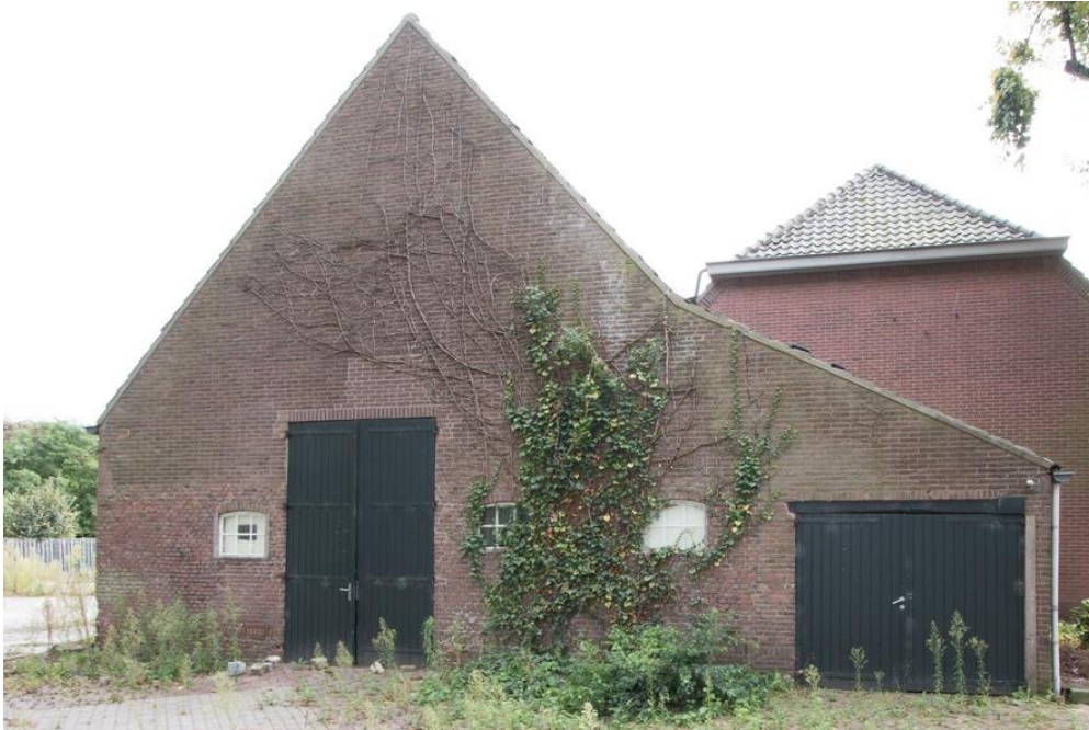
De korte linker zijgevel van de voormalige varkensstal.
