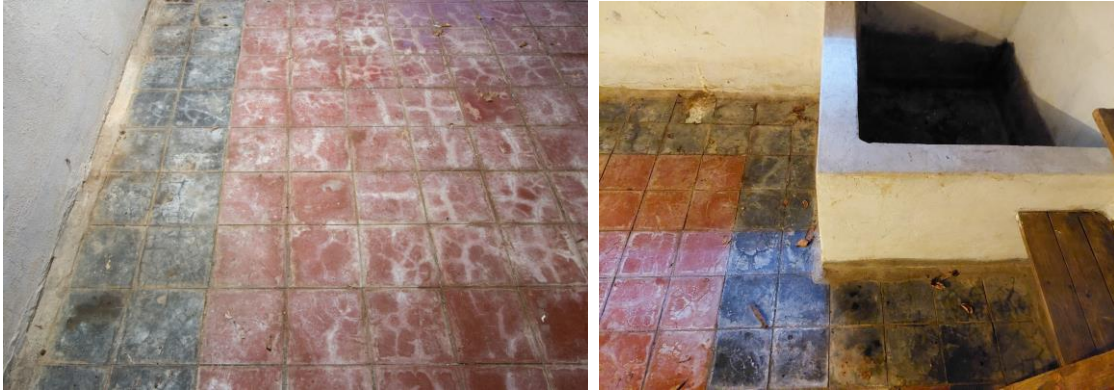
De keldervloer uit 1936.
