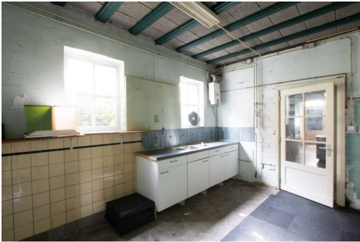
In de bijkeuken een tegellambrisering die vermoedelijk in de bouwtijd is aangebracht. We zien dit tegelwerk ook op de oorspronkelijke tussenmuur.
