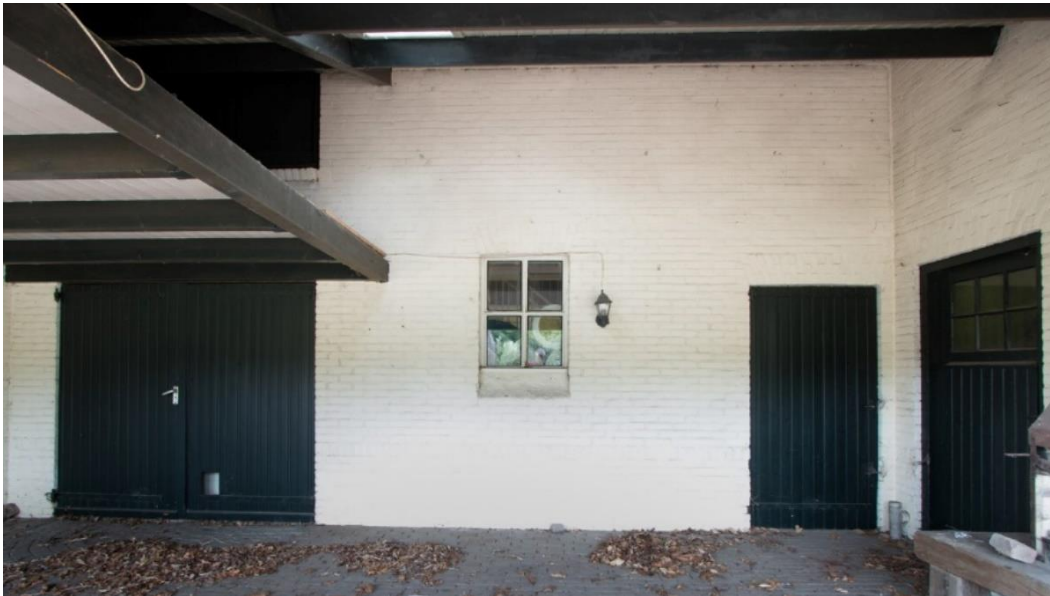
De achtergevel ter plaatse van het overdekte terras.
