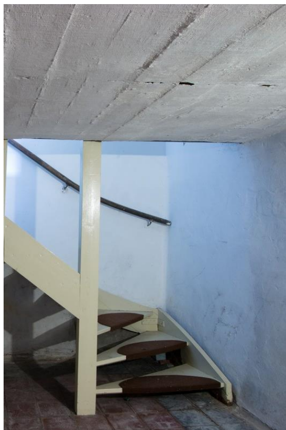
Halfsteensverband en donkerder trasraam in de voorgevel van het gebouw. Rechts het gewapend betonnen kelderdek, met bekistingssporen.
