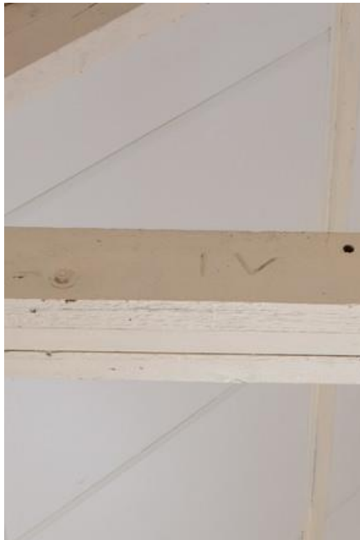
Detail van de voet van de spanten. Rechts in detail één van de telmerken (hier een IV).
