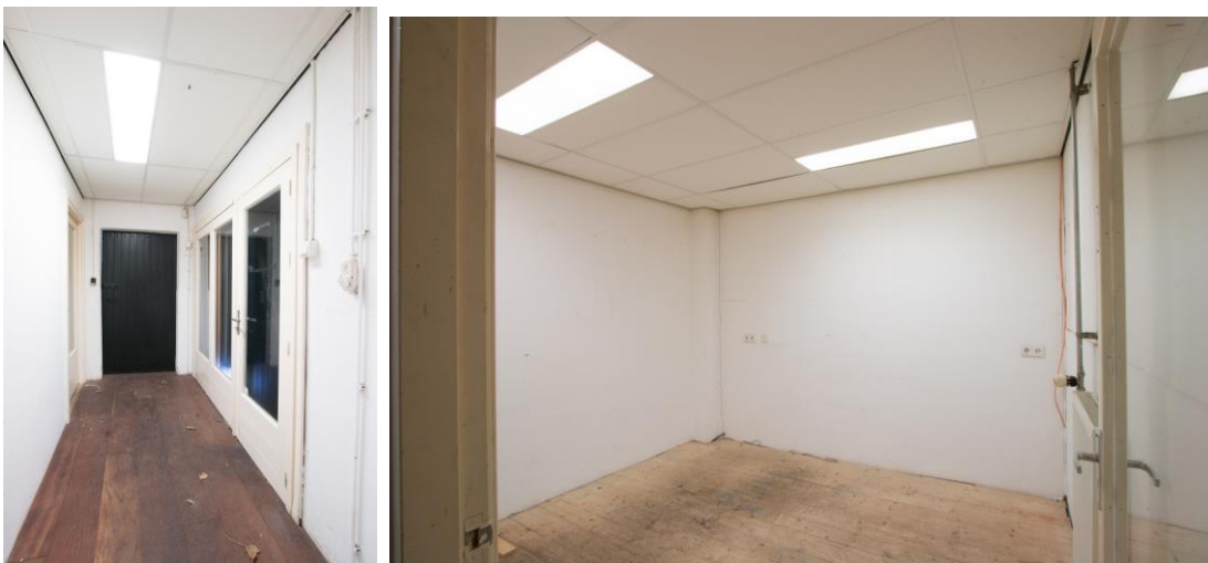
Gangetje langs de achtergevel met daaraan grenzende ruimte.
