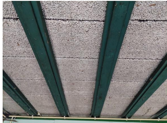
De cementvloer met recente(re) toplaag uit de winkelperiode. De broodjesvloer met elementen van gasbeton.
