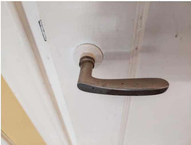
Een aantal deuren heeft nog krukstellen uit de bouwtijd van het pand.
