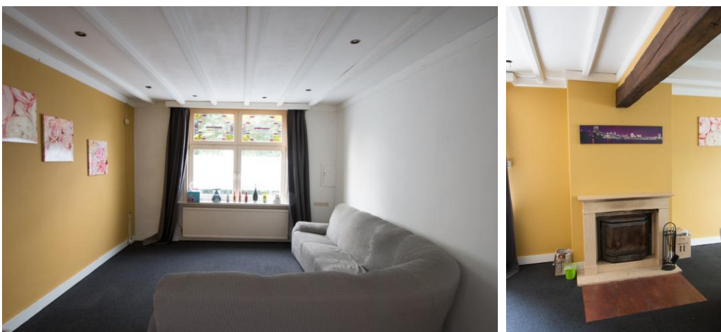
De voorkamer. Rechts de recente haard en de balk die in de plaats is gekomen van de kamerscheidende wand.
