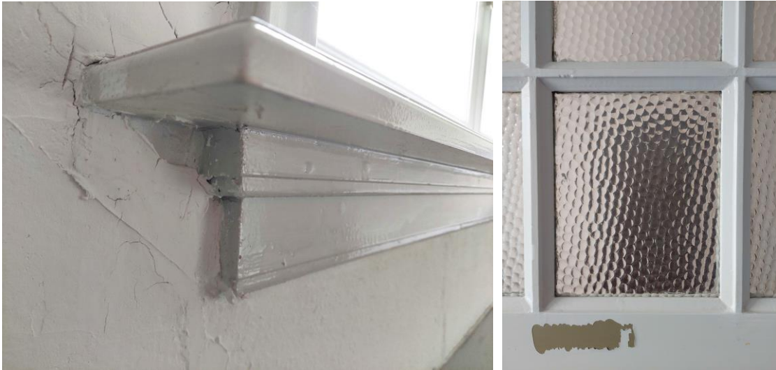
Oorspronkelijke vensterbanken bij de vensters in de voorgevel. Rechts sierglas in de kamerdeuren. Inkijk in de slaapkamers vanuit de gang, werd ermee voorkomen.
