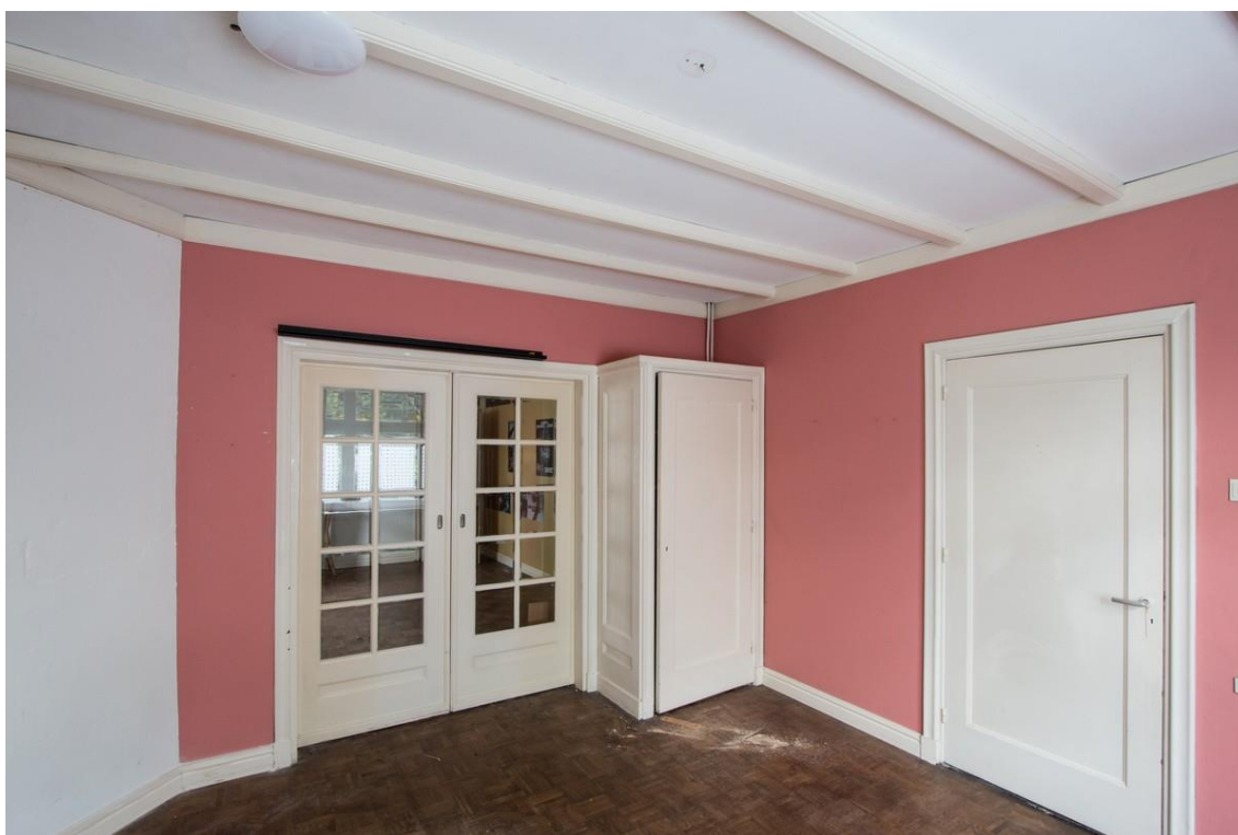
De voorkamer links. Alle deuren zijn oorspronkelijk, het plafond is secundair. Links het rookkanaal van een hoekschouw.
