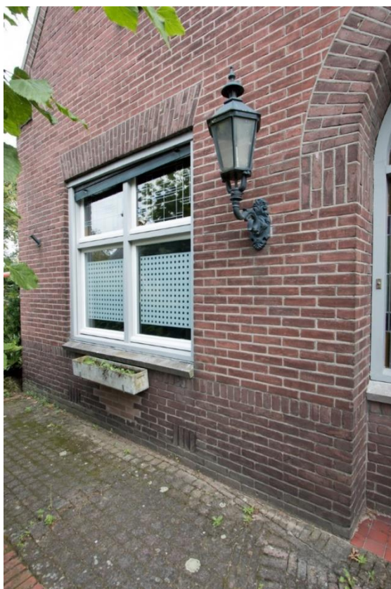
Halfsteensverband en donkerder trasraam in de voorgevel van het gebouw. Rechts het gewapend betonnen kelderdek, met bekistingssporen.
