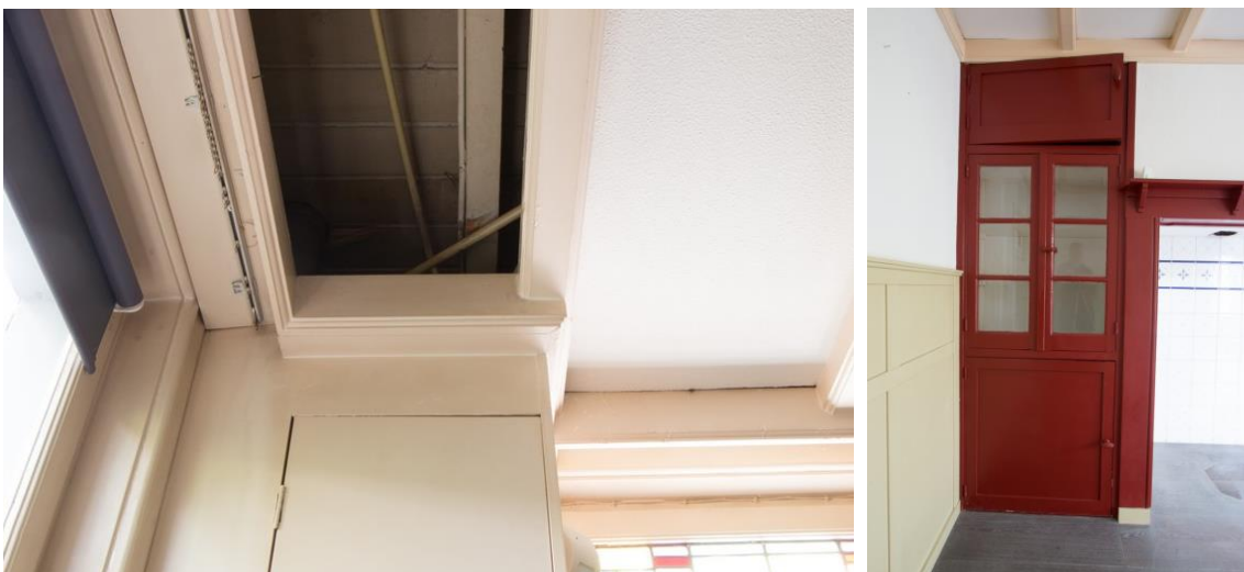
Geen stucplafond maar een beschilderd balkenplafond in de keuken.
