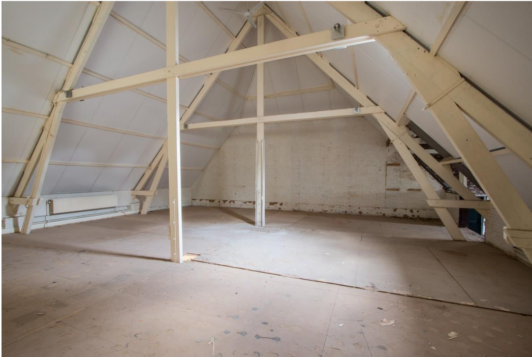
Twee van de kapspanten.
