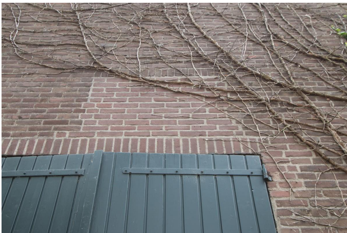
Dichtgezette gevelopening uit de tijd van de ophoging, later doorbroken met de huidige dubbele deuren, vermoedelijk uit 1970.
