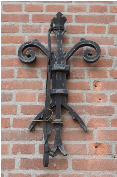
Sieranker en het enige oorspronkelijke venster van de voormalige varkensstal, uitgevoerd in ijzer.
