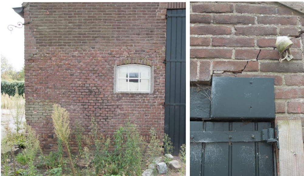
Twee fasen metselwerk en secundaire gevelopeningen in de gevel. Rechts de verbrede garagedeur (zie rollaag).
