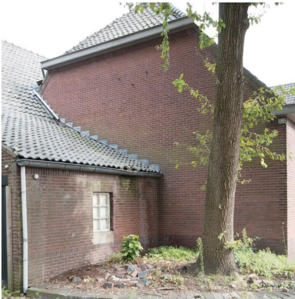
De korte gevel van het stalgedeelte met later aanbouwde garage. Rechts de dichtgezette deuropening (onderbreking rollaag).
