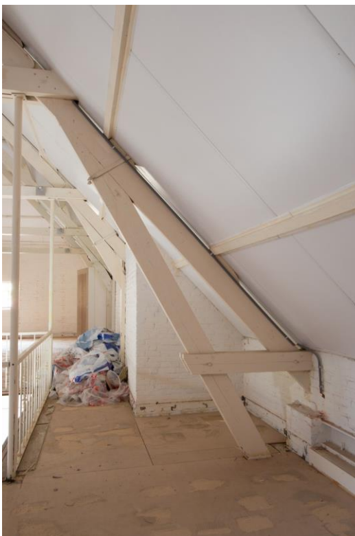
Detail van de voet van de spanten. Rechts in detail één van de telmerken (hier een IV).
