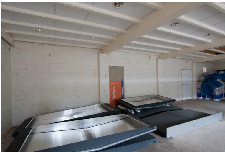
De achtergevel van binnenuit, met twee dichtgezette deuropeningen.
