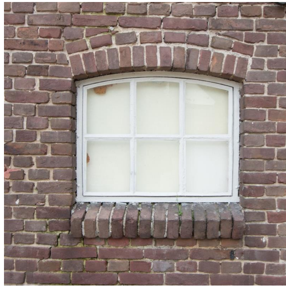
Sieranker en het enige oorspronkelijke venster van de voormalige varkensstal, uitgevoerd in ijzer.
