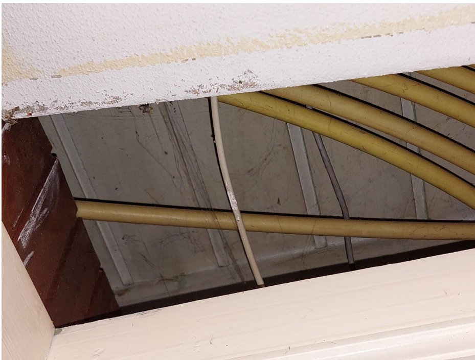
Het plafond in de gang en boven het verlaagde plafond de schroten van het voorzetwandje.
