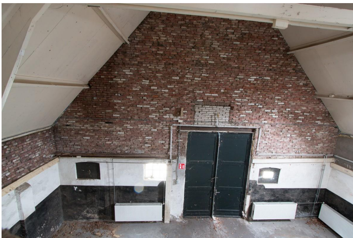
Zicht op de gevel van binnenuit. Ook hier tekent de ophogingsfase zich duidelijk af.
