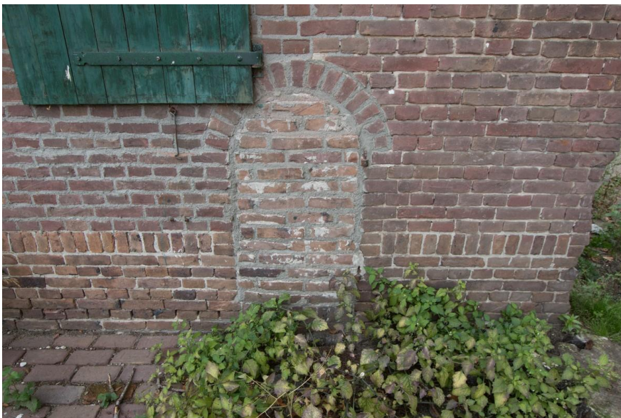
Dichtgemetselde opening voor één van de vier verdwenen staldeurtjes.
