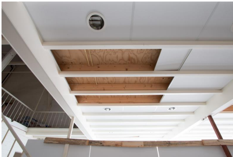
De vurenhouten balken en underlaymentplaten van de zoldervloer in het voormalige winkelgedeelte. Links één van de stalen kolommen die hier zijn opgesteld.
