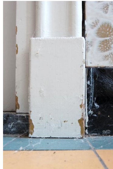
De oorspronkelijke aftimmering van de deurkozijnen. Rechts een houten neut. Onder de huidige toplaag gaan oudere afwerkingen schuil.
