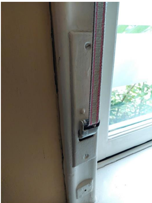
Bediening van de houten buitenrolluiken. Rechts aansluiting van niet-oorspronkelijke plint op de kachelmantel.
