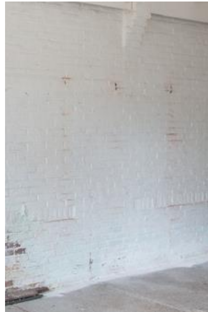
De korte gevel van het stalgedeelte met later aanbouwde garage. Rechts de dichtgezette deuropening (onderbreking rollaag).
