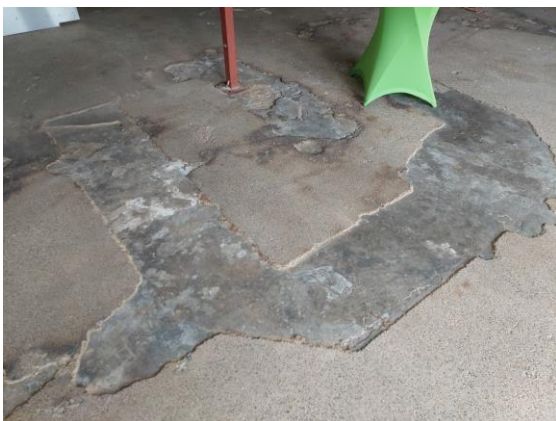
De cementvloer met recente(re) toplaag uit de winkelperiode. De broodjesvloer met elementen van gasbeton.
