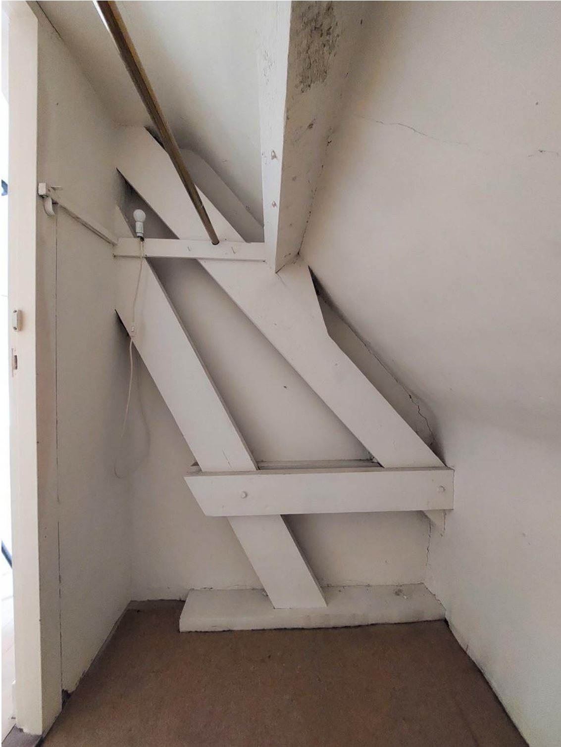
De delen van de verbeterde Hollandse spanten die op de verdieping te zien zijn.
