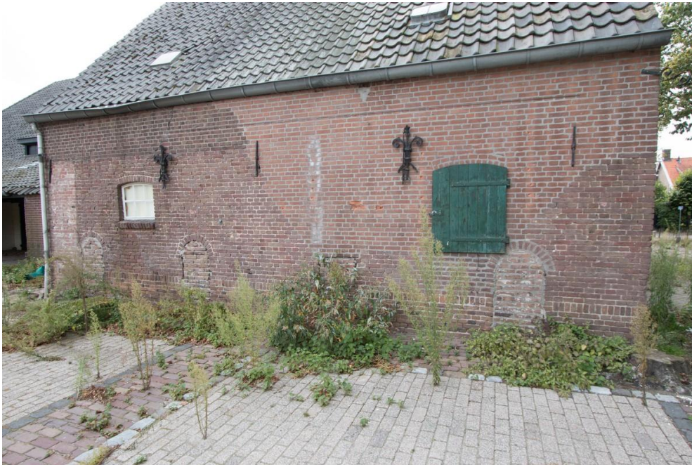
De lange gevel van de voormalige varkensstal met ten minste drie fasen metselwerk, waaronder ophoging en herstel. De ankers tonen aan dat er in het verleden een zoldervloer is geweest.
