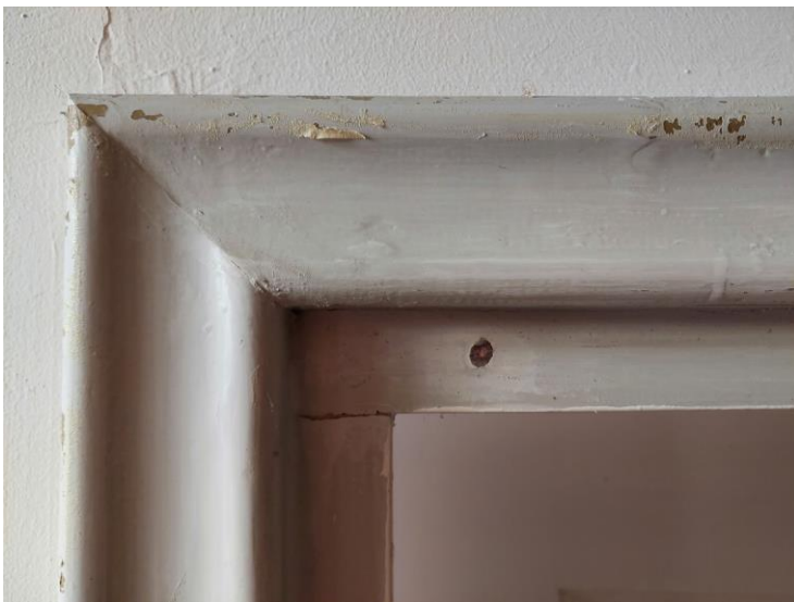
De oorspronkelijke aftimmering van de deurkozijnen. Rechts een houten neut. Onder de huidige toplaag gaan oudere afwerkingen schuil.
