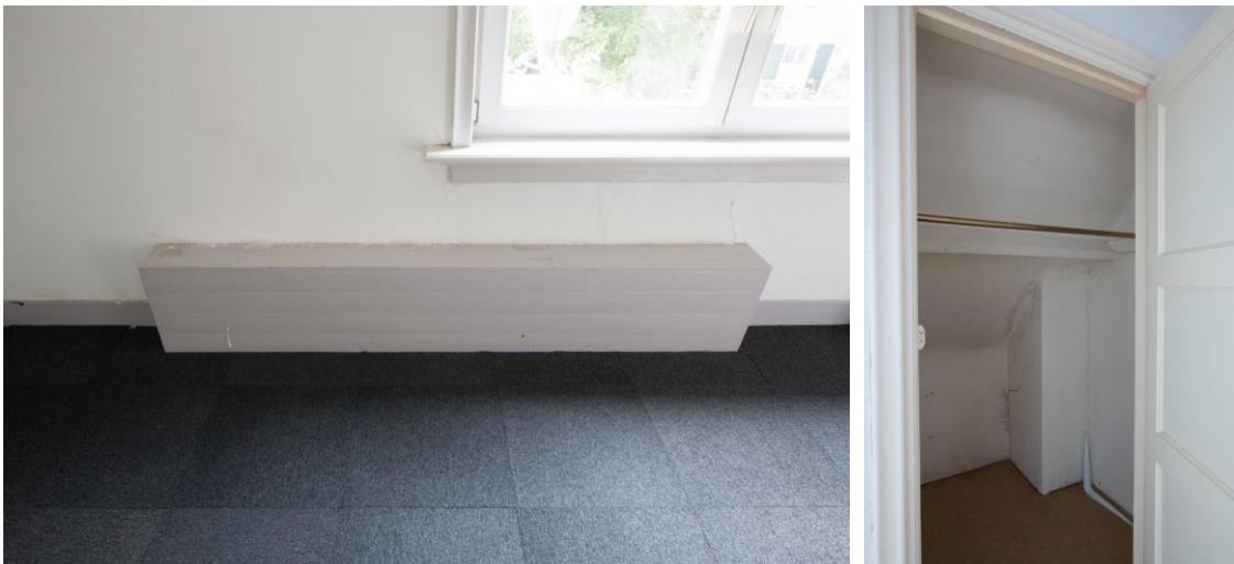
Eén van de rolluikkasten op de verdieping. Rechts een rookkanaal in één van de kasten.
