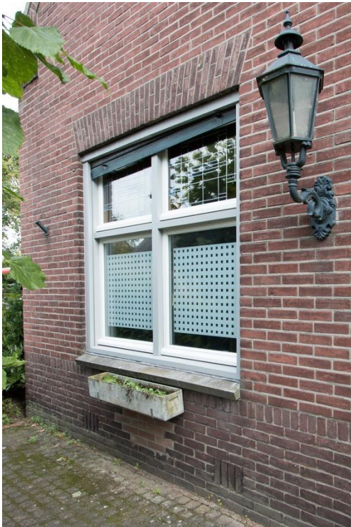
Links het kleurverschil tussen trasraam/strekse boog en de rest van het metselwerk. Ook zien we een stukje van een houten rolluik uit 1936. Rechts een detail van het kozijnhout en het vernieuwde raamhout met isolatieglas.
