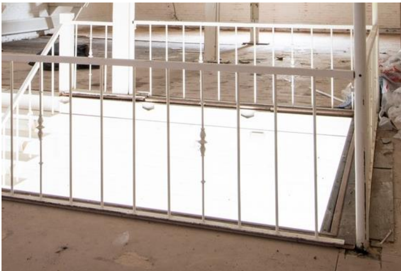
Ter plaatse van de vide zijn inkepingen te zien van verdwenen vloerbalken.
