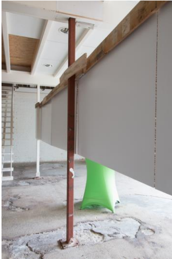
De vurenhouten balken en underlaymentplaten van de zoldervloer in het voormalige winkelgedeelte. Links één van de stalen kolommen die hier zijn opgesteld.
