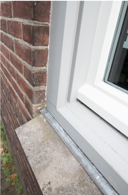
Links het kleurverschil tussen trasraam/strekse boog en de rest van het metselwerk. Ook zien we een stukje van een houten rolluik uit 1936. Rechts een detail van het kozijnhout en het vernieuwde raamhout met isolatieglas.
