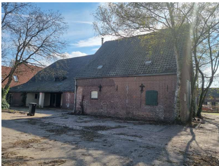
Achtergevel (oostgevel) berg 62
