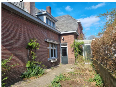
rechter zijgevel (zuidgevel) Berg 62
