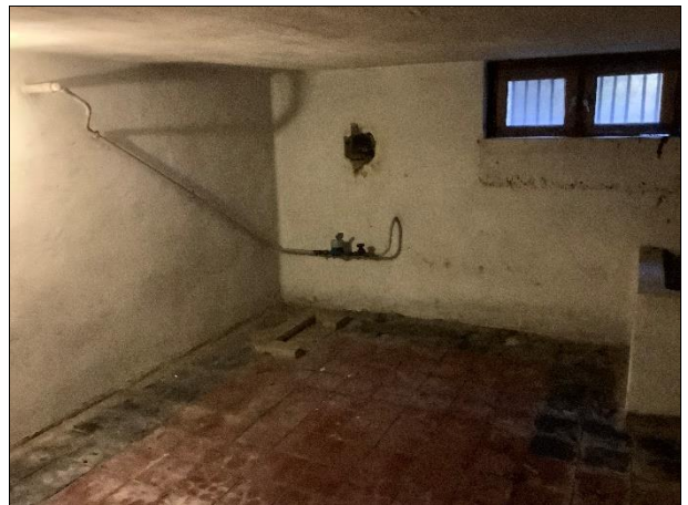
Foto 12 Foto van de kelder
