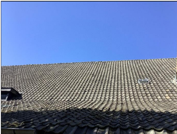
Foto 7 Foto van de nauw aansluitende dakpannen
