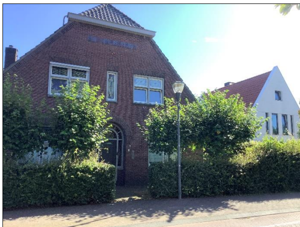
Foto 1 Aanzicht woongedeelte straatzijde
