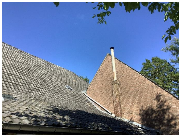
Foto 6 Aanzicht van de overkapping en de noordoostelijke aanbouw (verhoogd gedeelte aan de rechterzijde)
