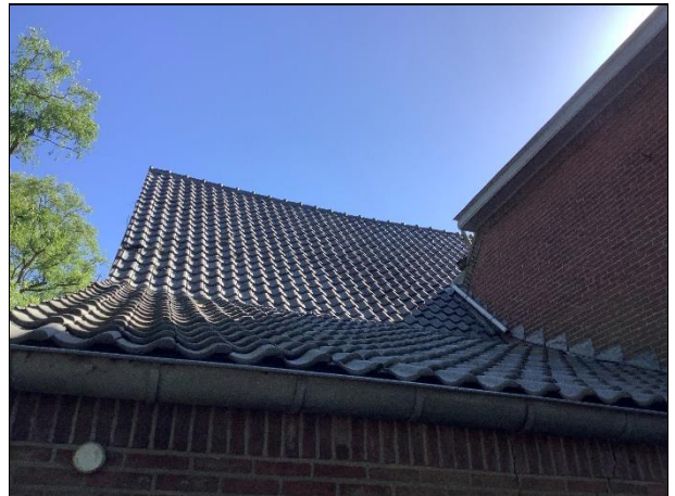
Foto 8 Foto van de nauw aansluitende dakpannen en dakafwerking
