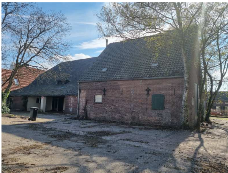
Achtergevel (oostgevel) berg 62
