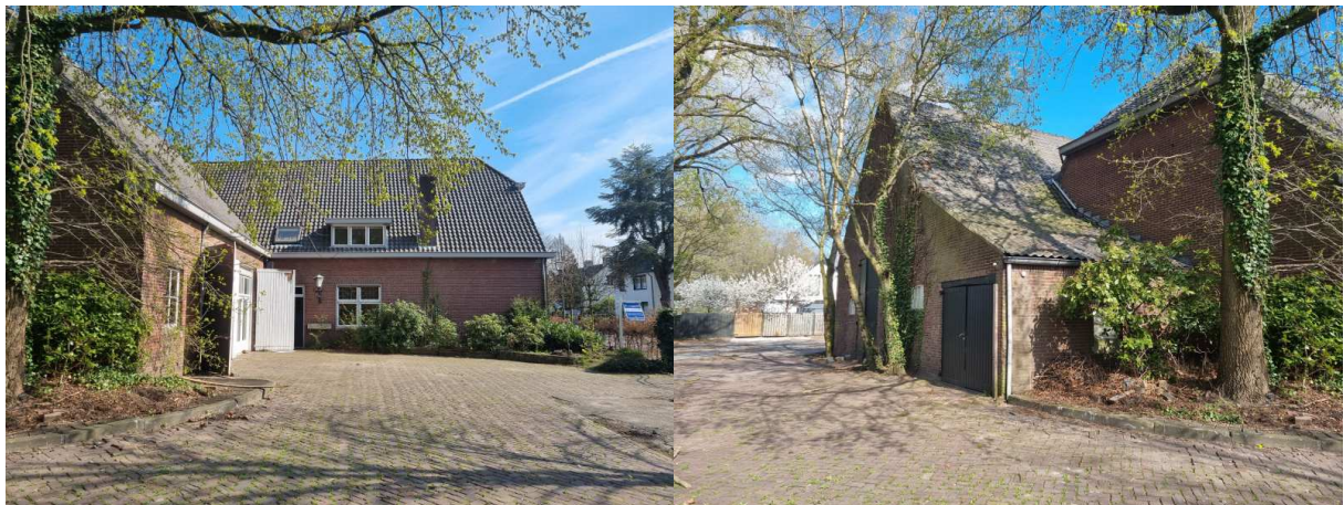
Linker zijgevel (noordgevel) Berg 62
