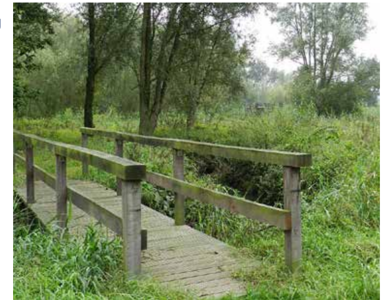
2. Houten fiets- en voetgangersbrug
