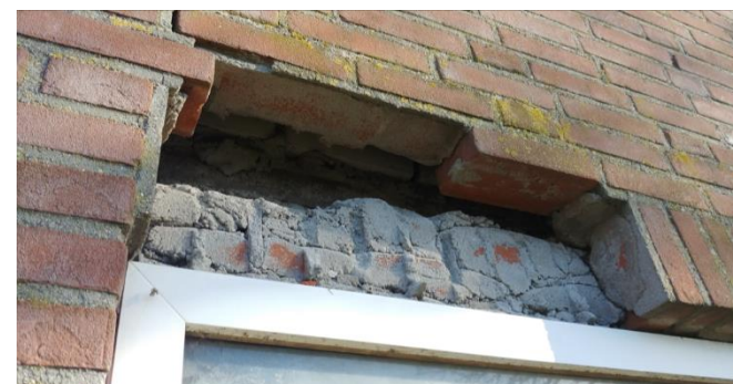
Figuur 11: Opening boven raam in de westelijk gelegen opstal
