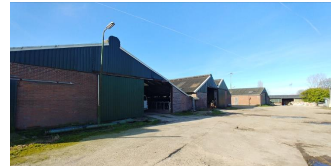
Figuur 5: Agrarische opstallen, welke gesloopt worden
