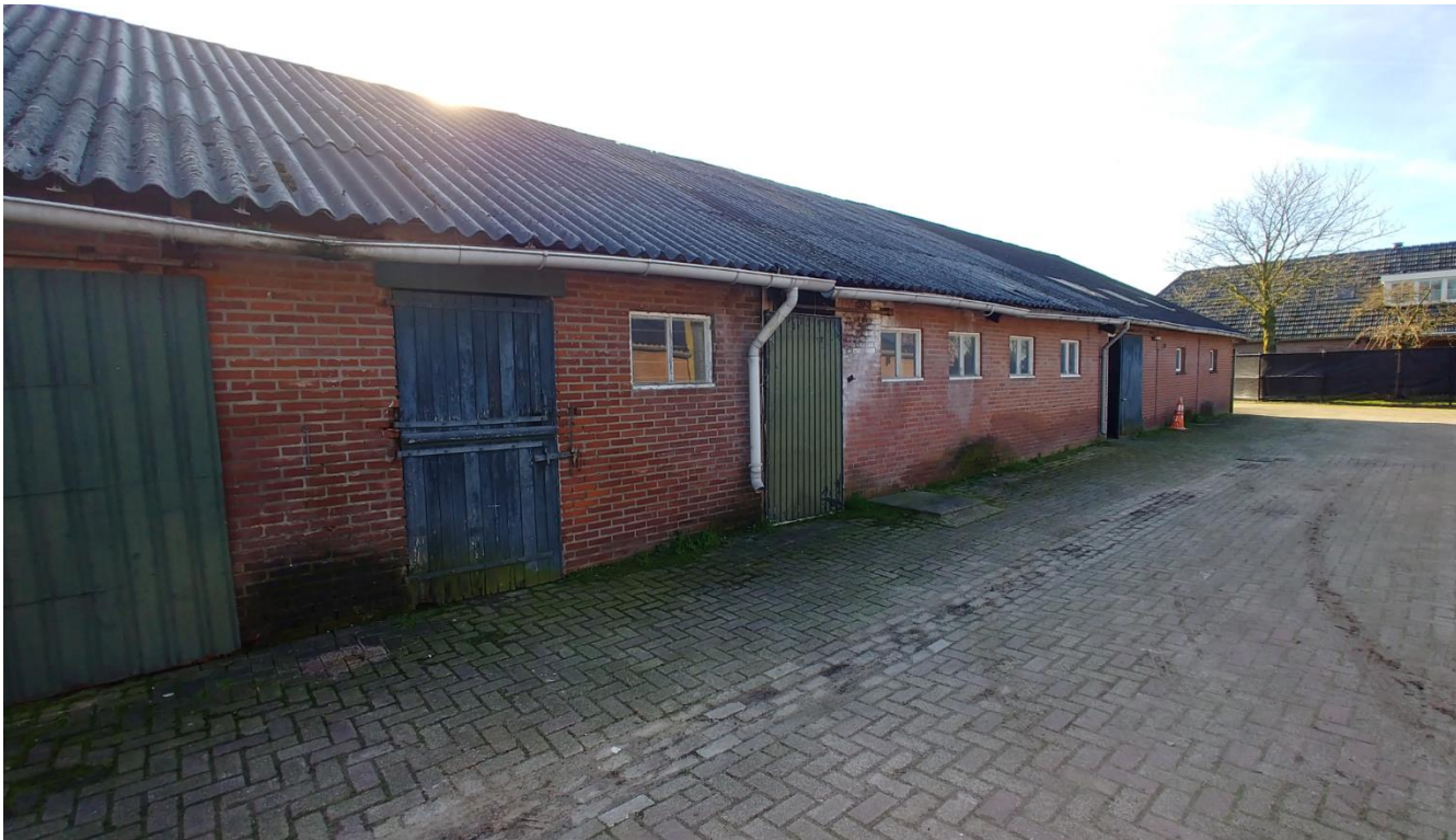
Figuur 4: Agrarische opstallen, welke gesloopt worden
