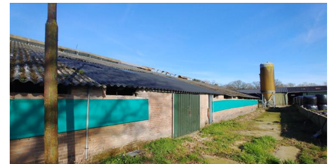
Figuur 6: Agrarische opstallen, welke gesloopt worden
