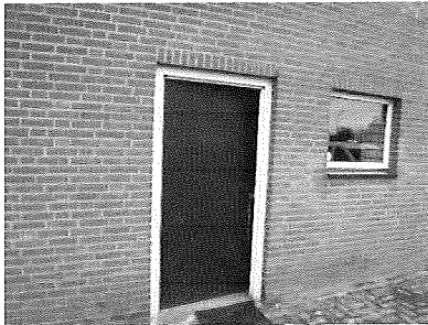
Foto 9 houten deur en kunststof kozijn
