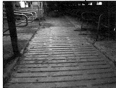
Foto 14 betonnen roosters
