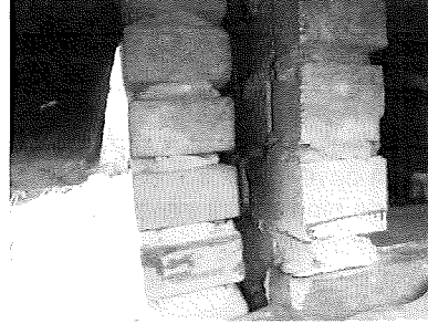
Foto 12 onverdachte spouwmuur
