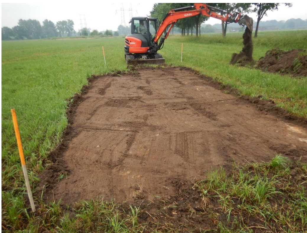
Figuur 8 Het aanleggen van proefsleuf 1
