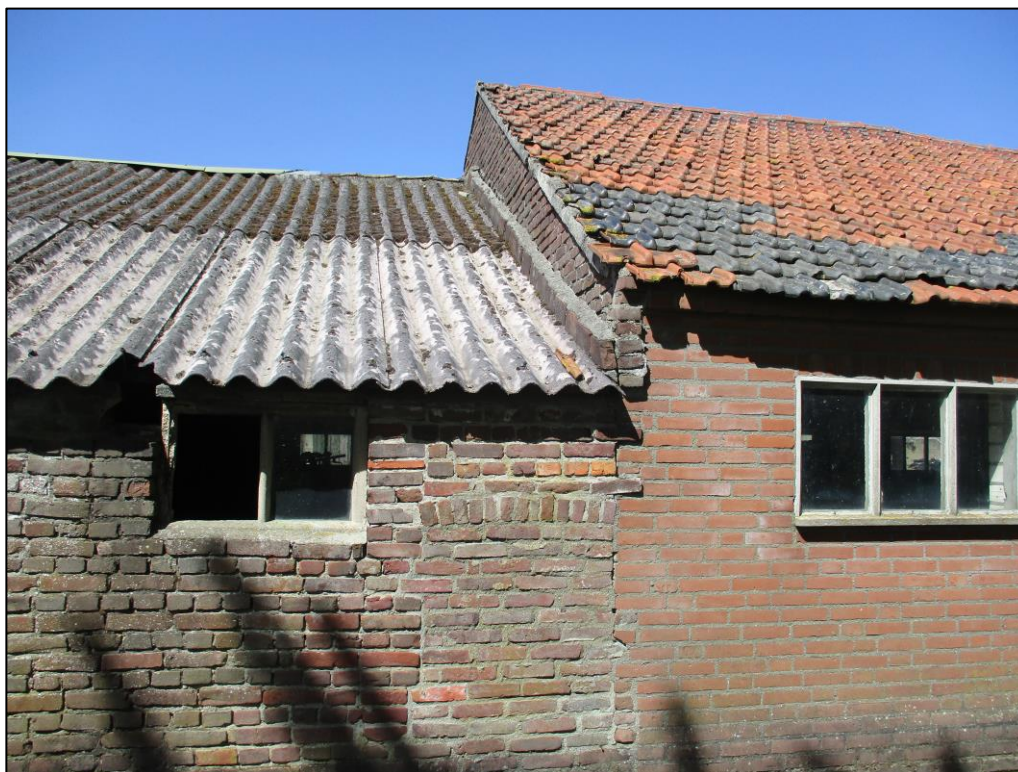
Figuur 2 De schuur (A) heeft deels een pannendak en deels een golfplaten dak zonder dakbeschot.
