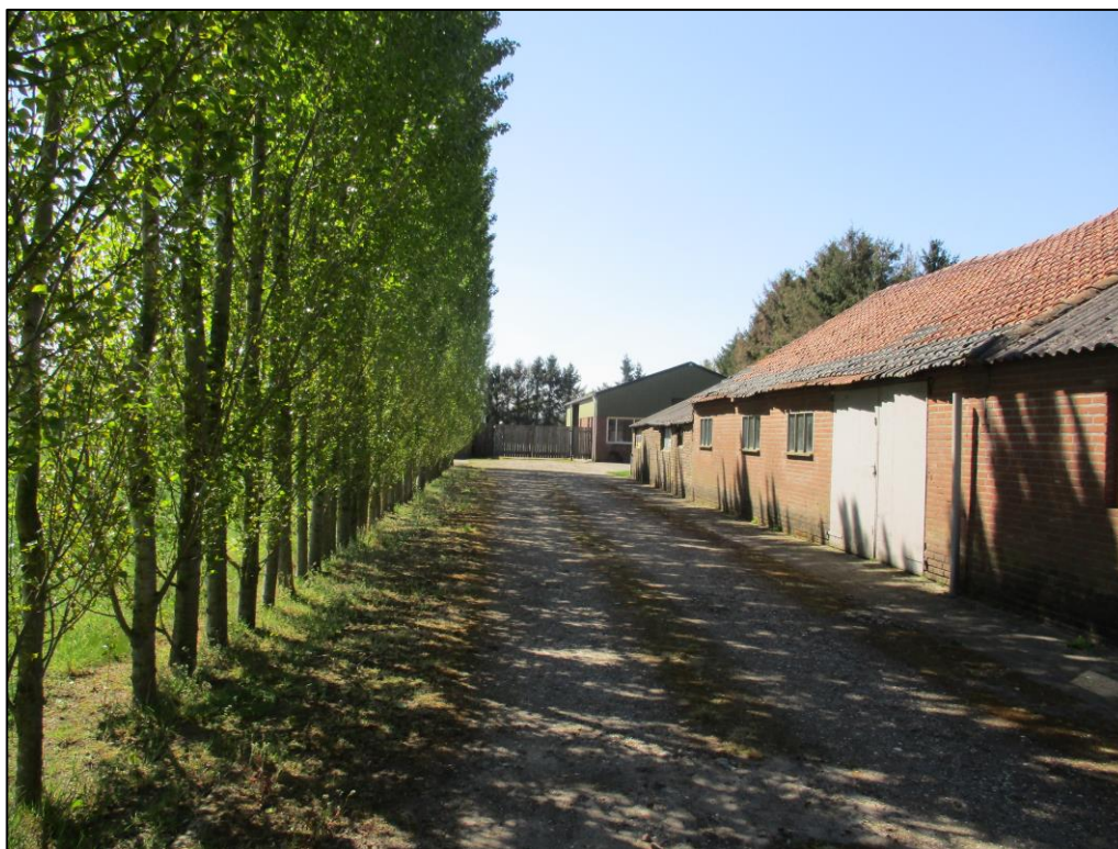
Figuur 1 De planlocatie is gelegen aan Rullen 7 te Gerwen. Hier de oprit naar de stallen en schuren met links de populieren bomenrij en rechts schuur A.
