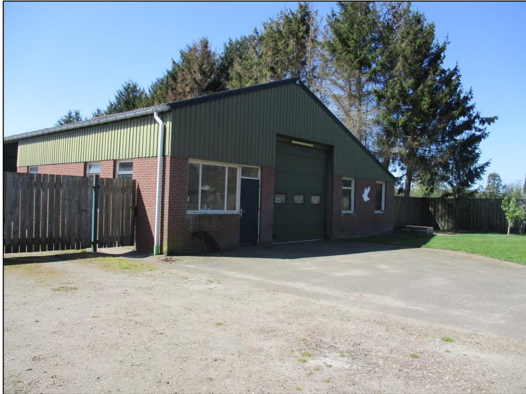
Figuur 3 De loods (C) is opgetrokken uit stenen muren en damwandplaten en is aan de westzijde open.
