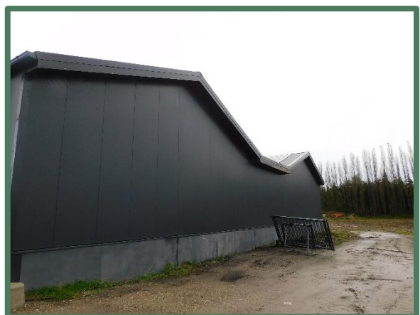
Achtergevel zuidelijke loodsen
