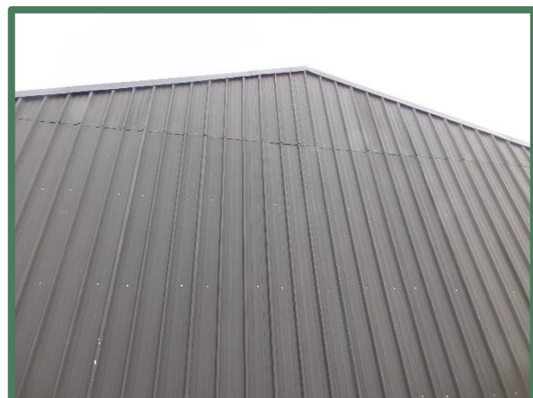
Aan te bouwen gevel van loods
