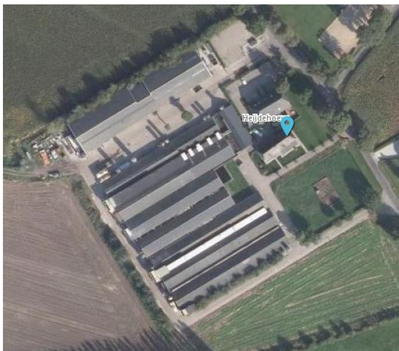
Figuur 1 : Situatie varkensbedrijf vóór de sloop van de stallen
