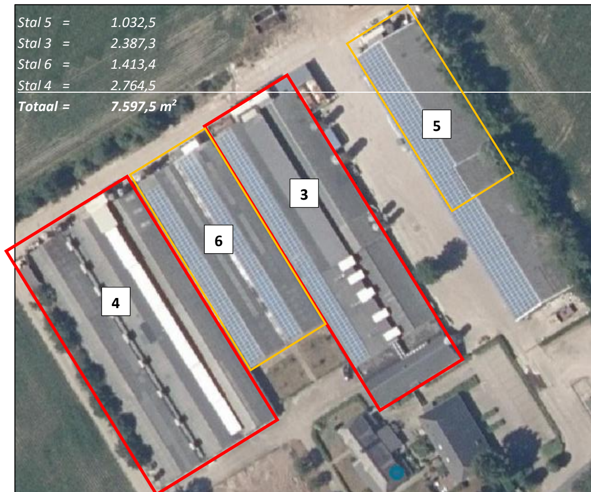
Figuur 4: Te slopen varkensstallen
