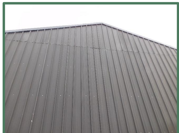
Aan te bouwen gevel van loods
