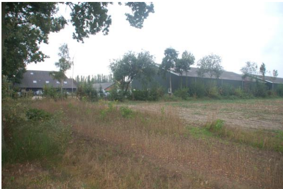
Afbeelding 12: Loods met links kantoor
