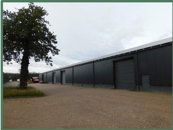
Zijgevel noordelijke loods
