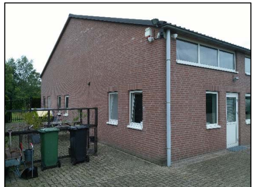
Foto 4. Loods ten noorden van het plangebied
