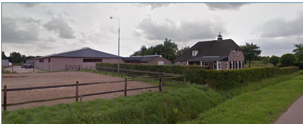
Afbeelding 4. Zicht vanaf Alvershool op de bedrijfswoning en stallen aan de Alvershool 1.
