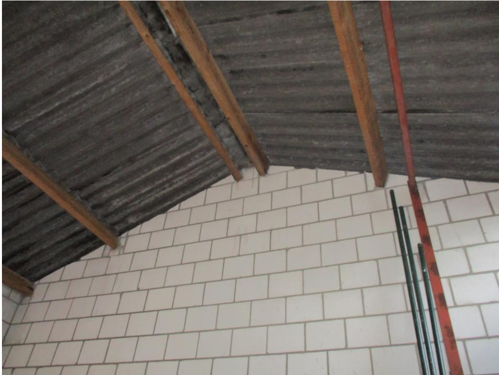
Figuur 5 In schuur B zijn onder de golfplaten geen ruimten aanwezig waar mogelijk verblijfplaatsen van vleermuizen aanwezig kunnen zijn.
