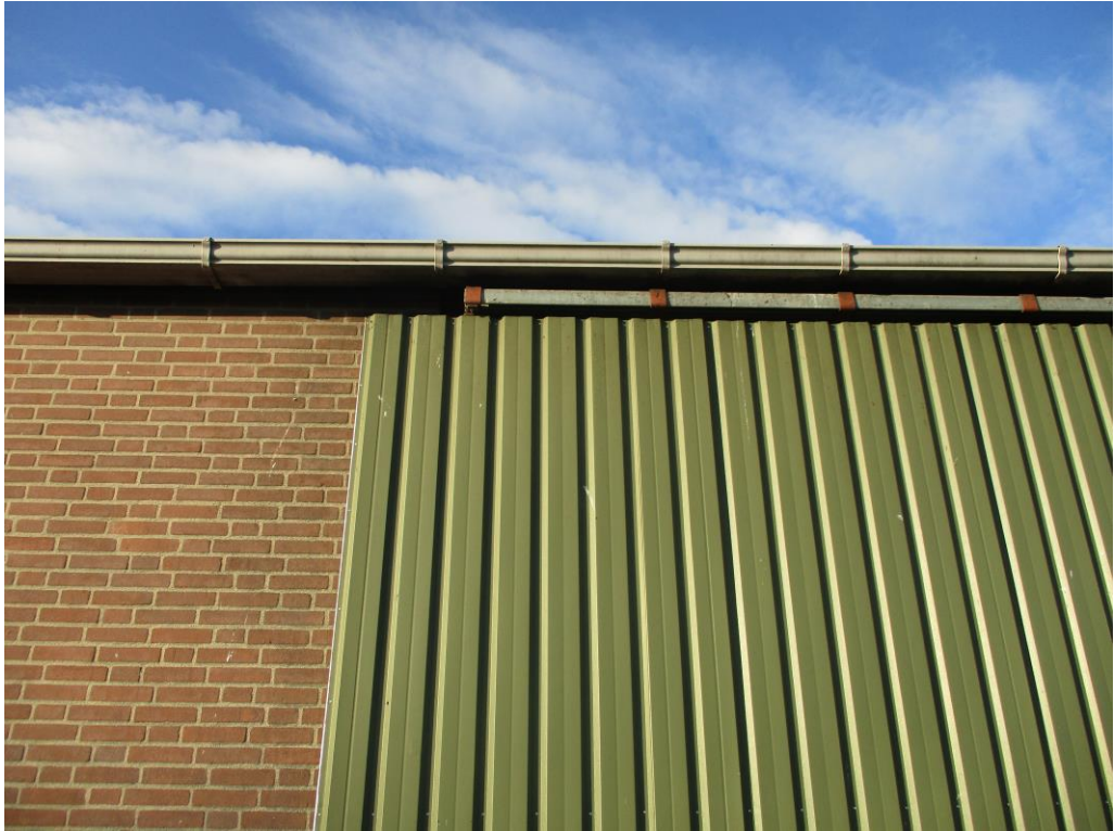
Figuur 3 De noordelijke schuur (B) is opgetrokken uit gemetselde muren en heeft een grote damwandplaten deur.
