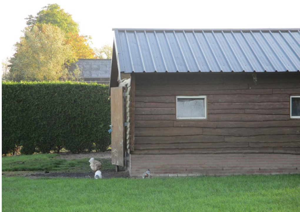
Figuur 2 De kippenren met kippen bestaat uit houten potdeksels en heeft een damwandplaten dak. Deze blijft behouden in de beoogde ontwikkelingen.
