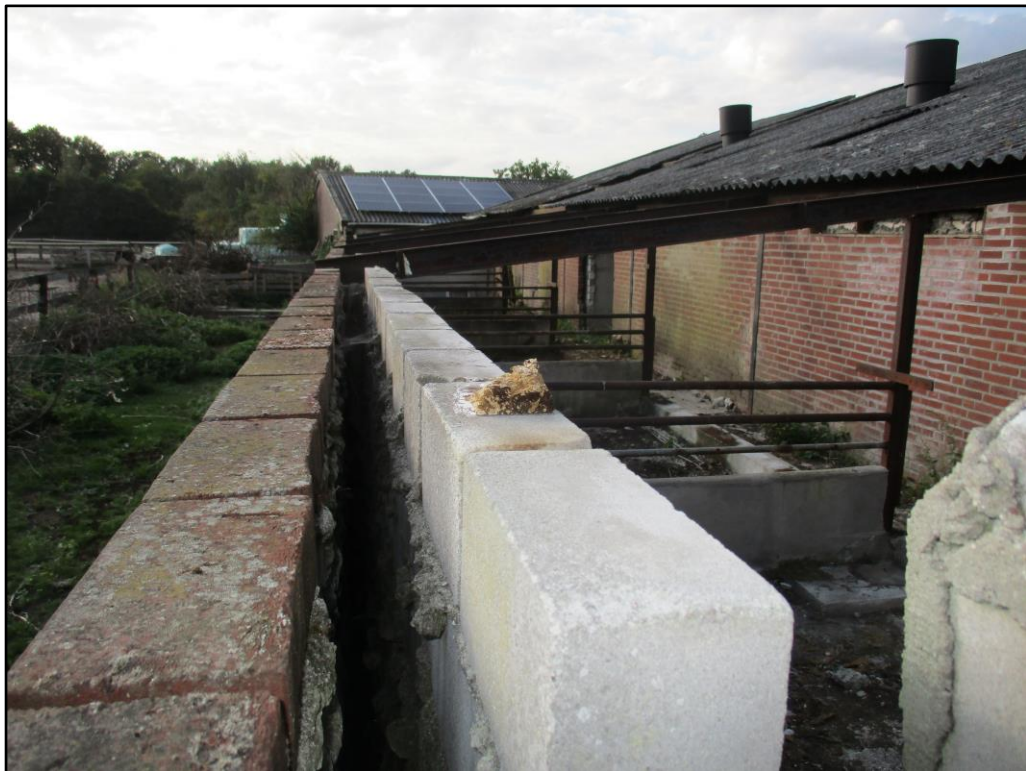
Figuur 4 De luchtsponwen van de aanbouw van stal B zijn open en het dak is verwijderd.
