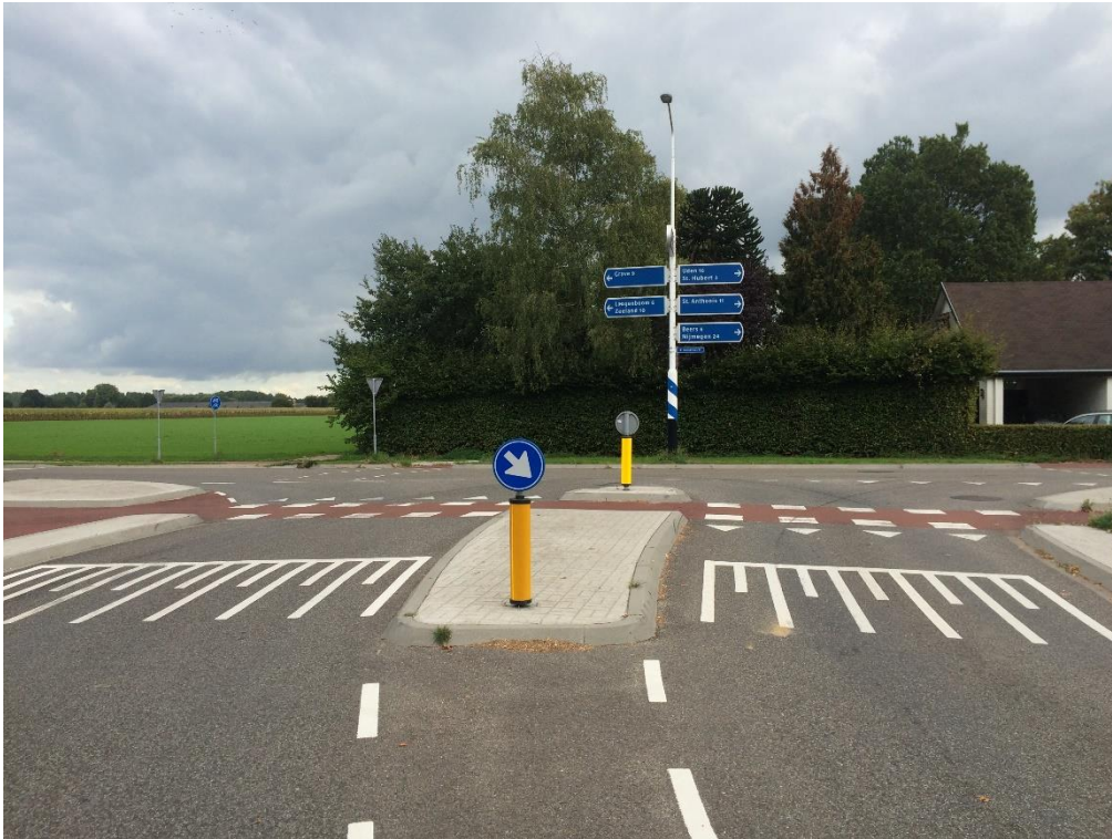
Wegprofiel Hoogveldseweg richting het noordoosten en aansluiting op de Karstraat
