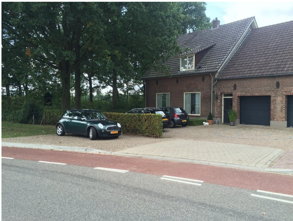
Bestaande woonboerderij Hoogveldseweg 47 zoals aanwezig ten noordoosten van het plangebied
