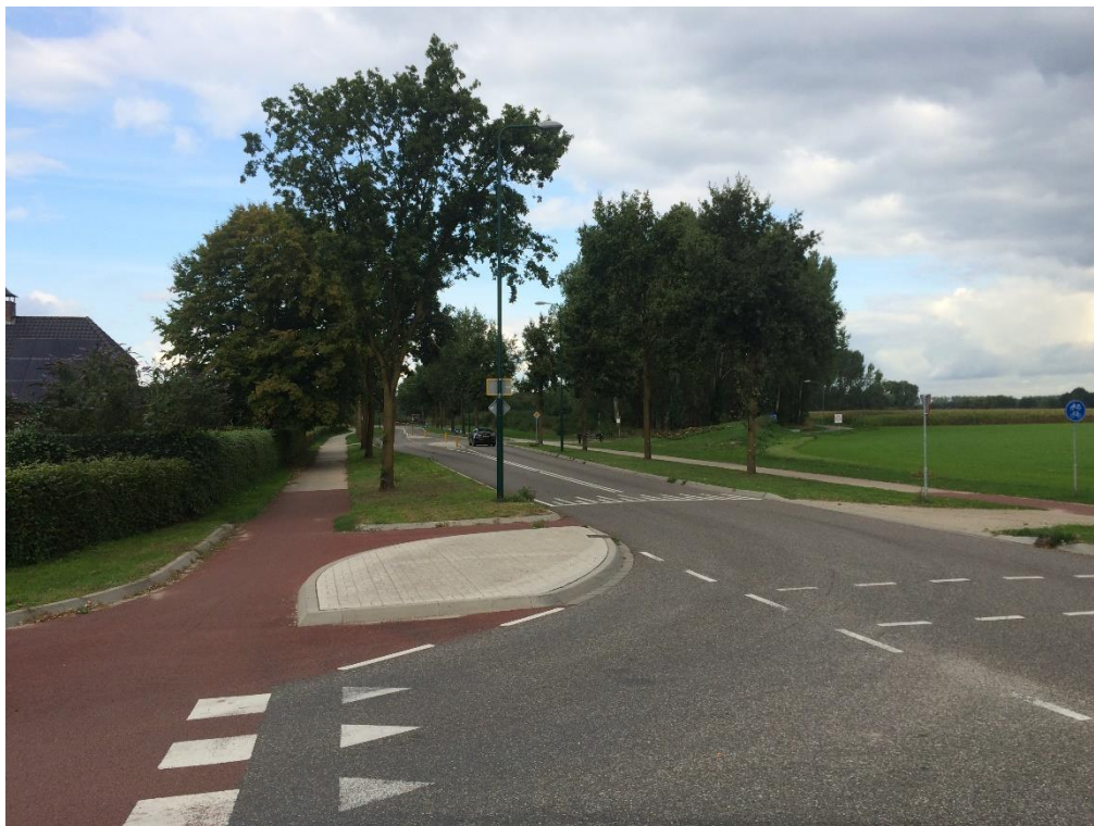
Wegprofiel Karstraat richting het noordwesten
