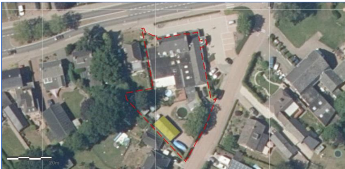
Figuur 3 Locatie schuur met asbestverdacht dak.
