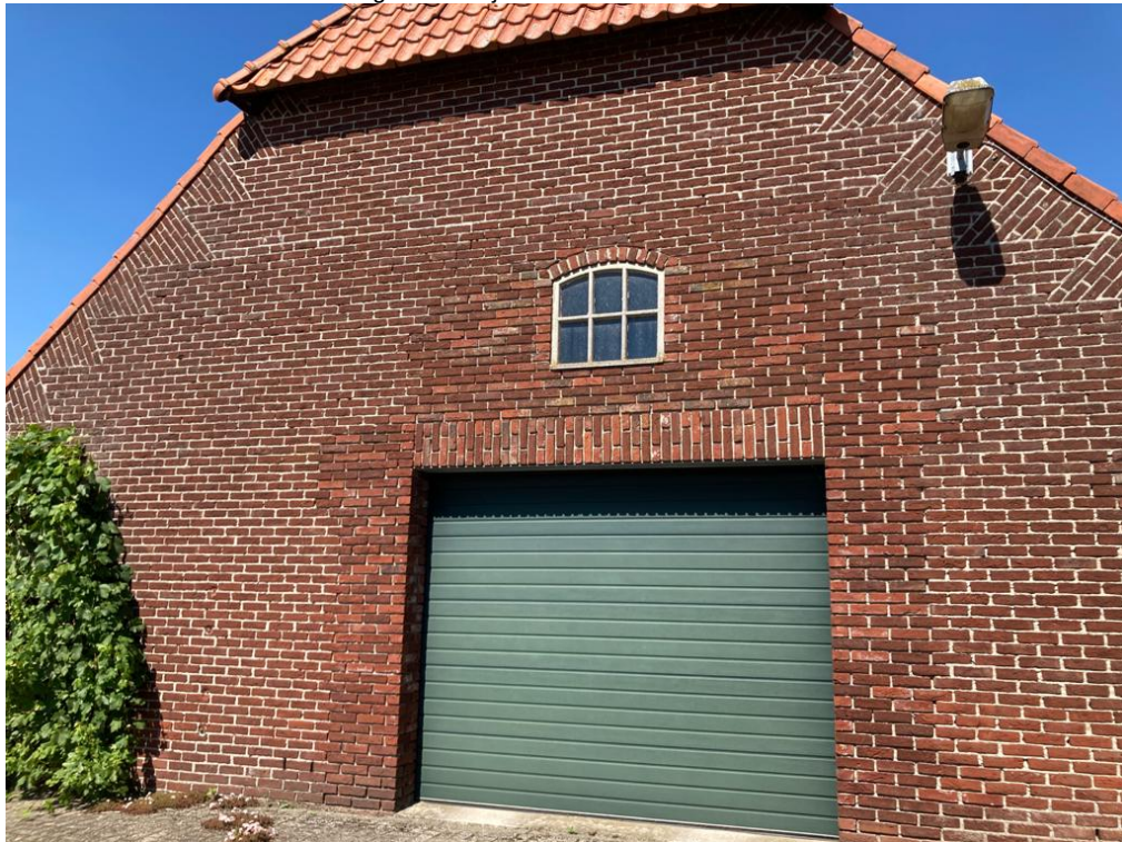
• Afbeelding 4: achterzijde woonhuis
