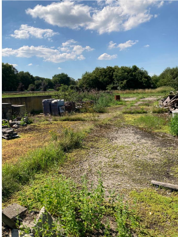
• Afbeelding 13: sleufsilo met opslag bouwmaterialen
