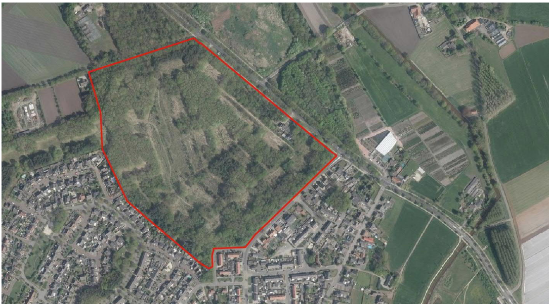
Afbeelding 1: Luchtfoto plangebied. Bron: Google.
