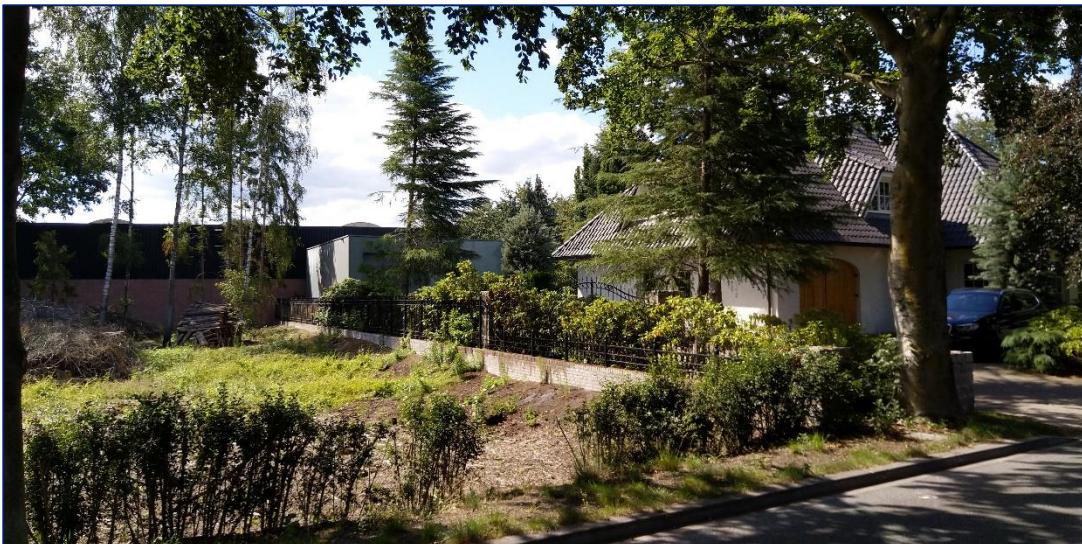
Bedrijfswoning en bedrijfsgebouw Hertsweg 4 grenzend aan plangebied
