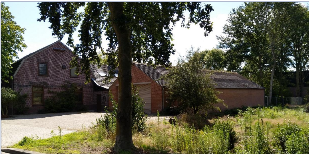
Bedrijfswoning en bedrijfsgebouw Hertsweg 8 grenzend aan plangebied
