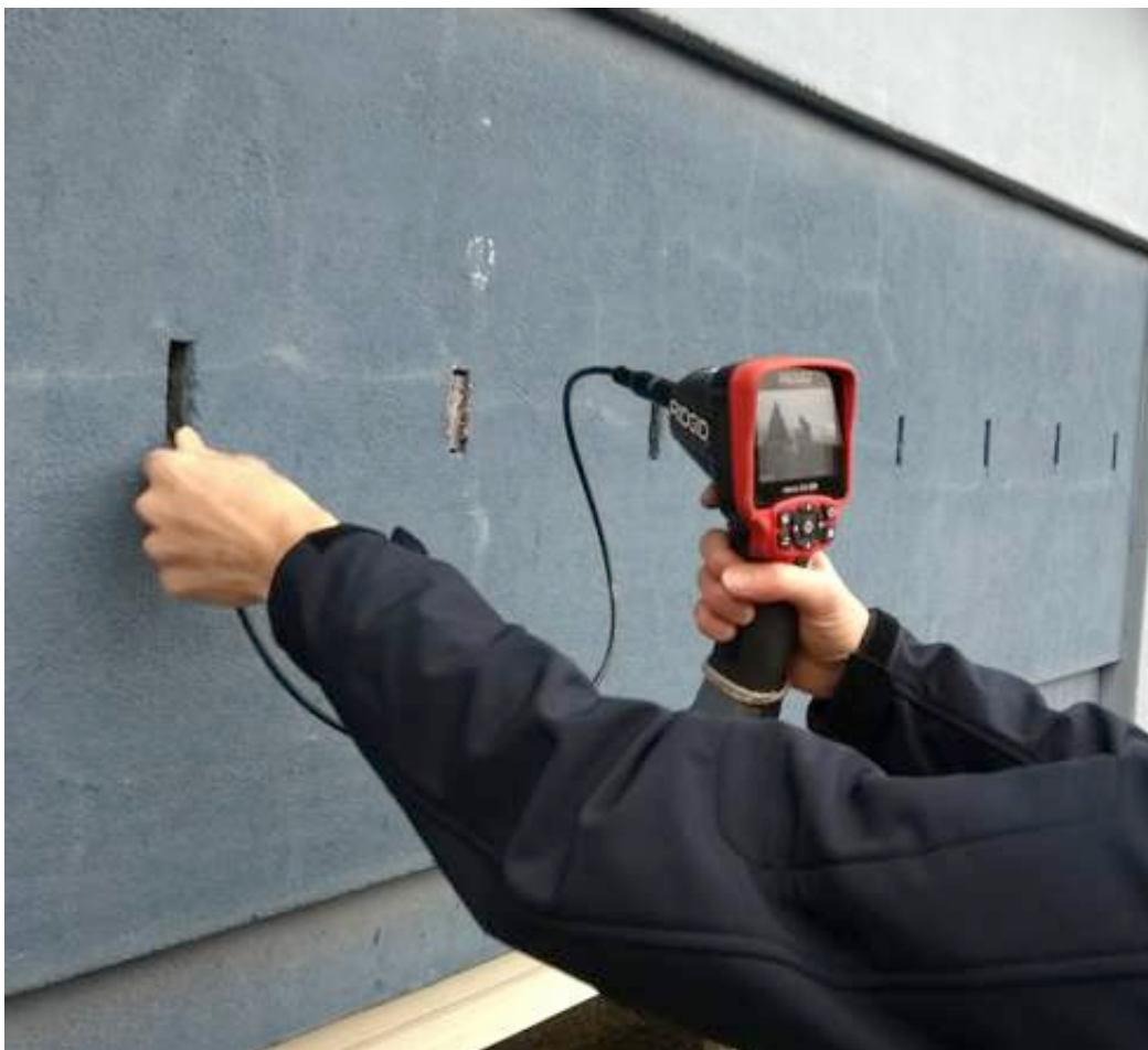
Figuur 4 Inspectie van de openingen in voorgevel concertzaal met endoscoop.
