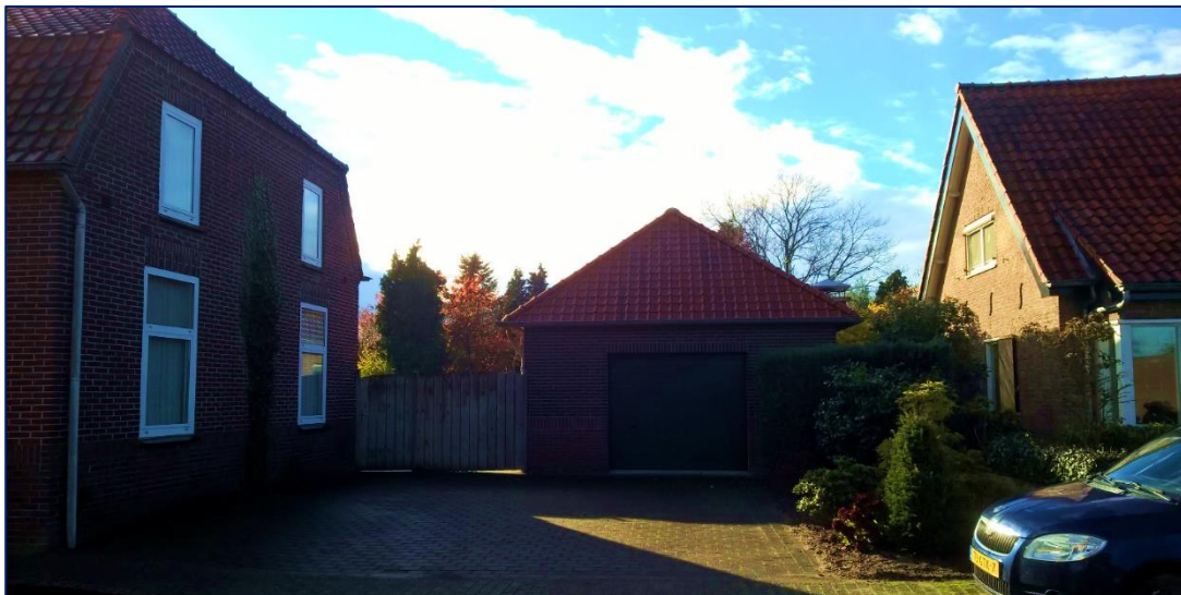
Plangebied met bestaand bijgebouw
