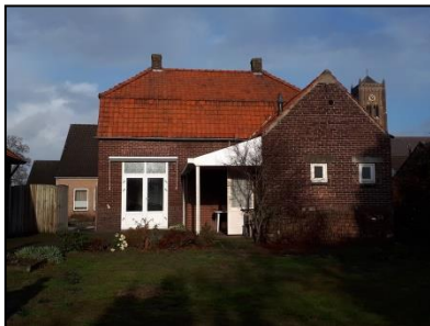
Figuur 3. Achterzijde woonhuis.
