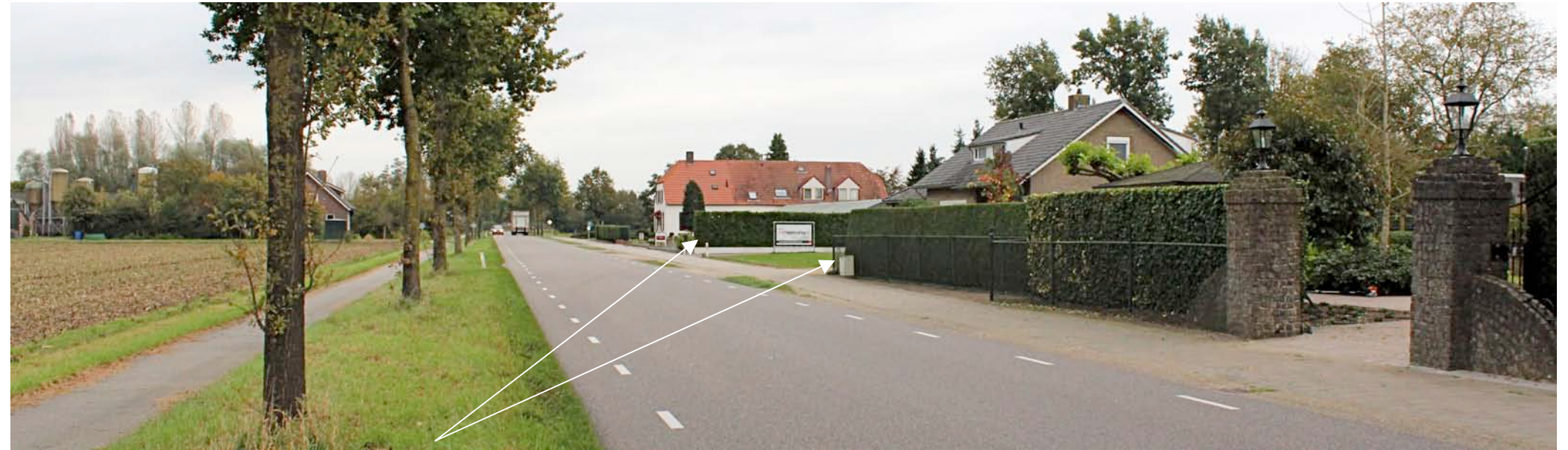
vanaf de Zeelandseweg komend uit het zuidwesten
