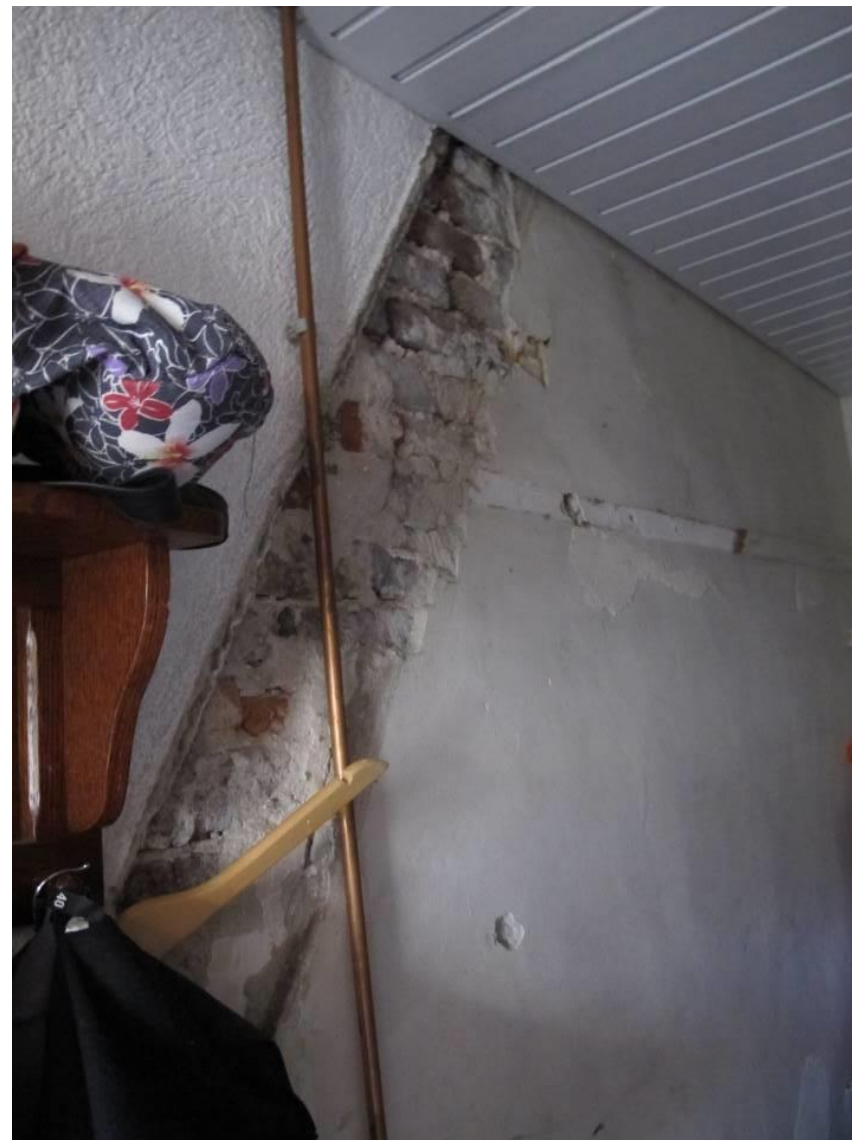
De linker gangwand behoort tot de oorspronkelijke opzet van het voorhuis. Dit is herkenbaar aan het oudere muurwerk ter plaatse van de verwijderde trapboom.
