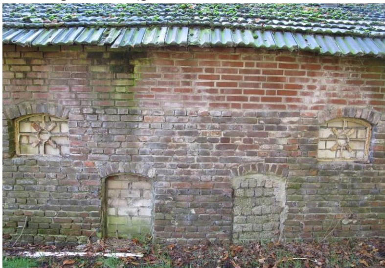
Detail van de zijgevel van het achterhuis met diverse dichtgezette oudere stalvensters en mestluikjes.
