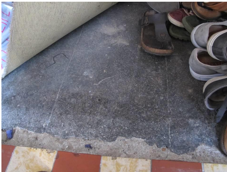
Restant van een oudere granitovloer die vermoedelijk bij de oorspronkelijke woonkeuken behoorde voordat hier een gang werd aangelegd.
