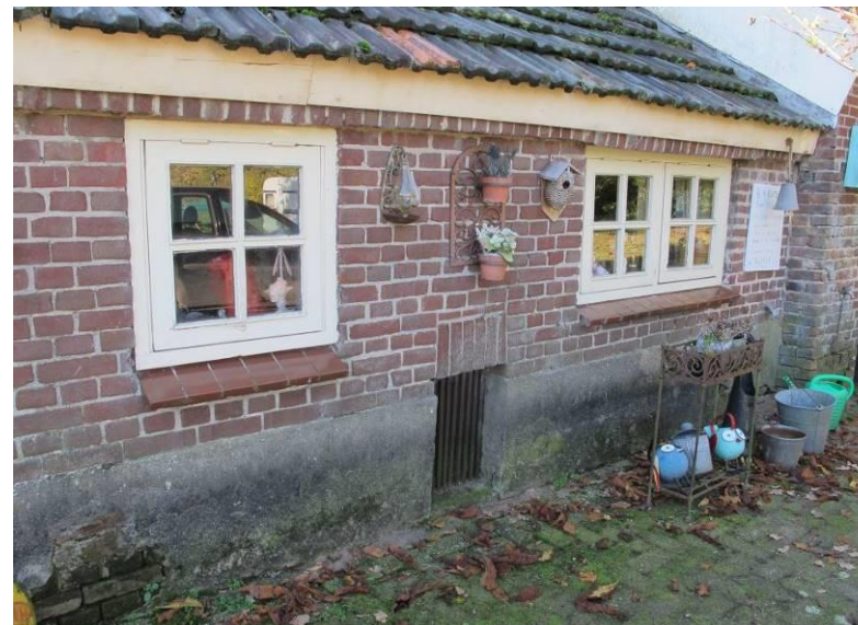
Rechter zijgevel van het woongedeelte, waar ondanks de vernieuwing van de vensters de oorspronkelijke opzet bewaard bleef.
