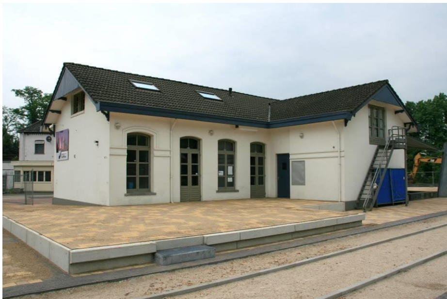
Recente afbeelding van het als Rijksmonument aanwezen Station Mill. Bron: www.rijksmonumenten.nl
