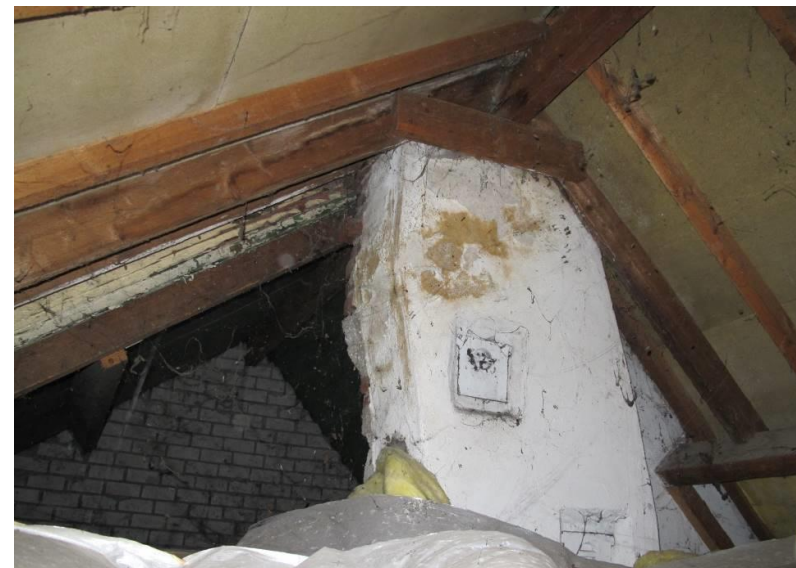
Het boven de brandmuur aanwezige oudere rookkanaal.
