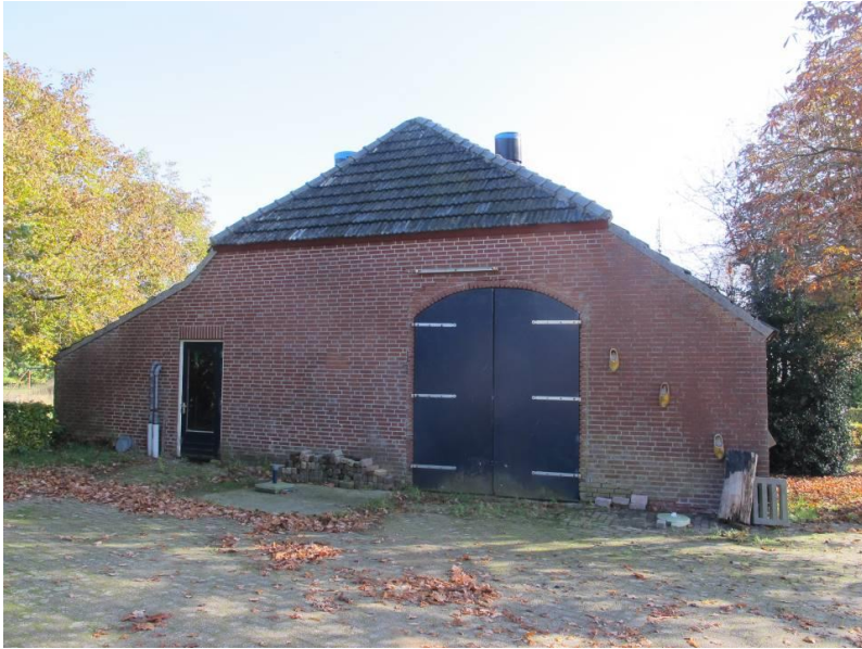
Overzicht van de achtergevel, waarvan het buitenblad werd vernieuwd.
