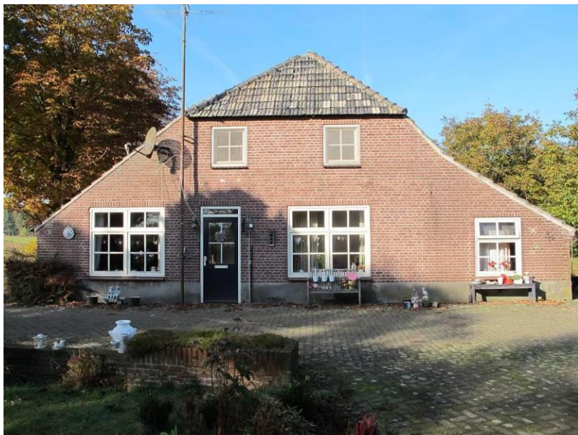
Overzicht van de vernieuwde voorgevel.
