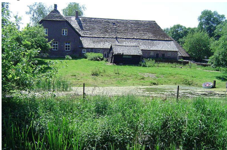
Boerderij "De Meysche Voort", Meisevoort 16 te Mill. In oorsprong vermoedelijk 18e eeuwse boerderij van het middenlangsdeeltype met dwars geplaatst voorhuis. Bron: www.rijksmonumenten.nl
