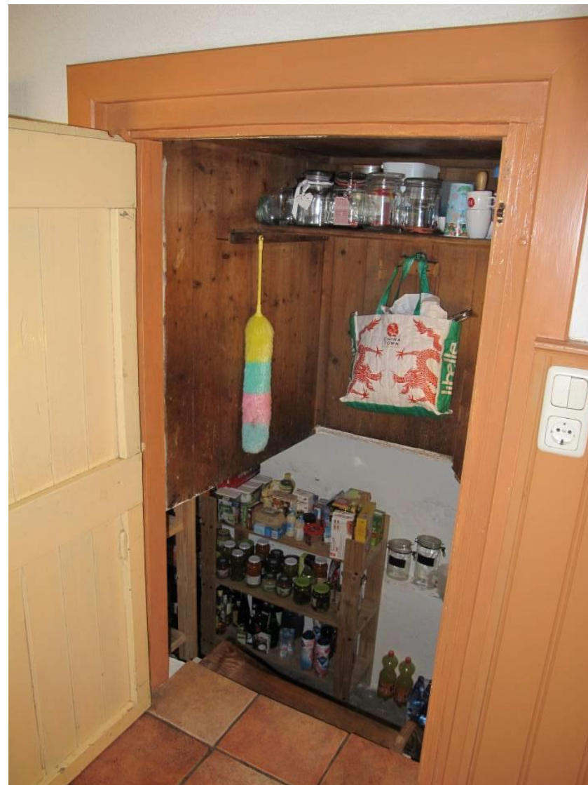
Keldertoegang met nog de oorspronkelijke opgeklampte deur.
