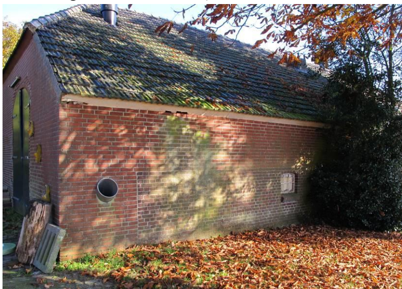
Achterste deel van de linker zijgevel, met aansluitend op de achtergevel een vernieuwde zone. De hele gevel werd verhoogd.
