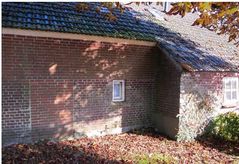
Linker zijgevel met ter hoogte van de brandmuur een verspringing als gevolg van de uitleg van het voorhuis in 1898.
