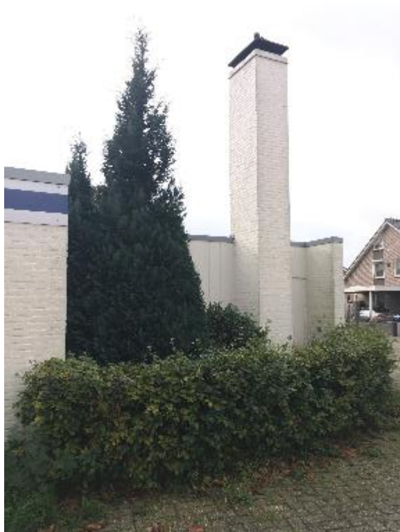
Figuur 2 Aan de noordzijde is een klein deel opgetrokken uit rabatdelen, tevens heeft het pand een grote uitstekende schoorsteen.
