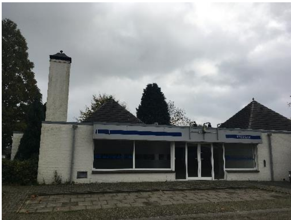
Figuur 1 Het gebouw bestaat uit gemetselde muren met open stootvoegen een plat dak met een klein puntdakje. Aan de westzijde is een grote glazen pui aanwezig.
